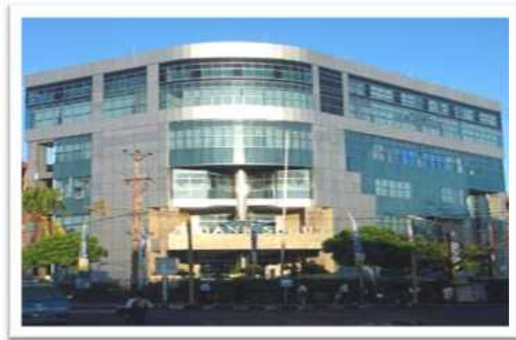
Gambar 4 : Gedung Bank Sulut Pada Tahun 2000-an
