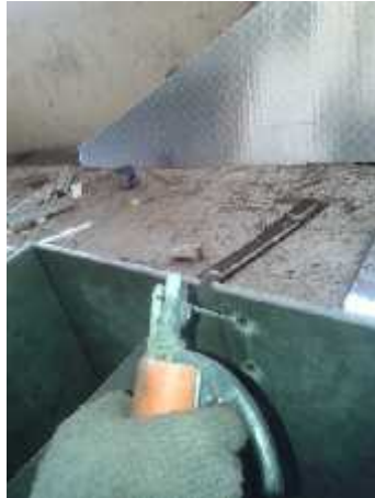
Gambar 4. Pengelasan Untuk Kedudukan Sekat
