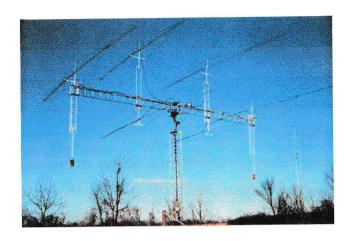
Gambar 1. Anda memiliki keterbatasan soal tempat ? inilah jawaban dari problem anda itu. Disini di tunjukan suatu antena beam yang di dirikan di atas taing setinggi 120 feet untuk bidang frekwensi HF di tambah dengan antena yagi yang digunakan untuk bidang frekwensi VHF. Sepanjang menaranya diberikan alat untuk memanjat, sehingga antena-antena tersebut mudah diatur.
