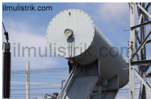
Gambar 8. Konservator Trafo
