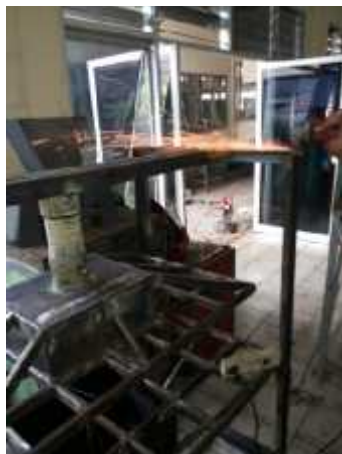
Gambar 5. penggerindaan rangka tiang penyangga
