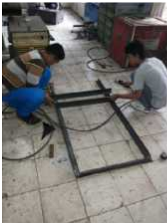
Gambar 2. penyetingan tiang rangka
