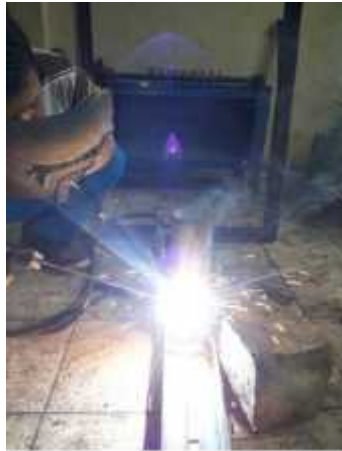
Gambar 4. penyambungan pipa dengan rangka tiang penyangga
