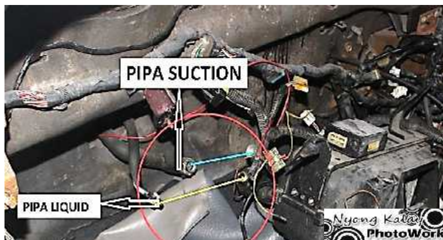
Gambar 3.3 Melepaskan pipa pada evaporator
