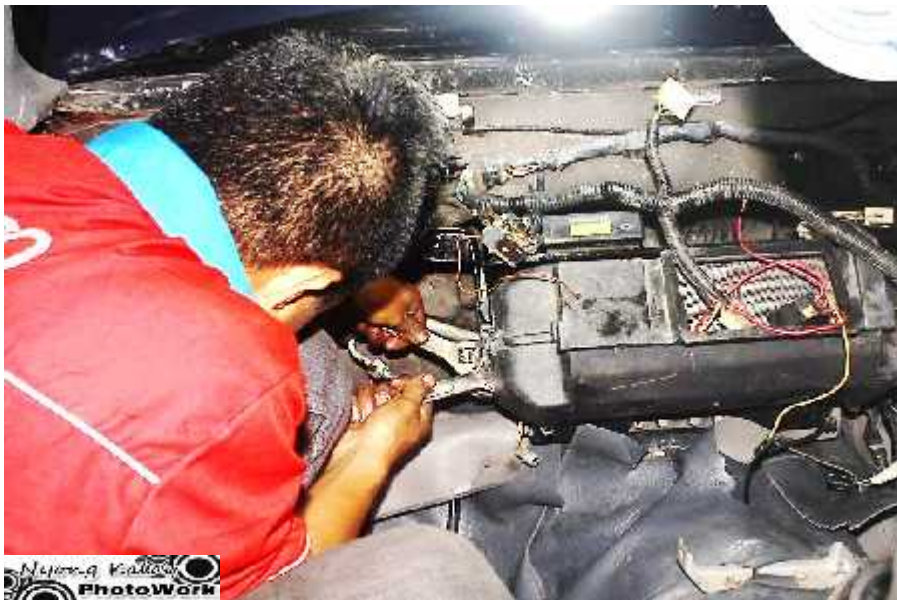
Gambar 3.20 Pemasangan kedua pipa pada evaporator
