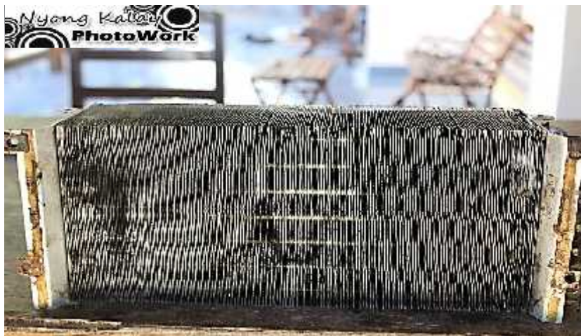
Gambar 3.13 Evaporator sudah bersih.
