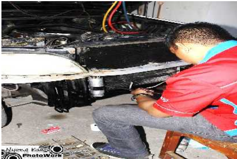
Gambar 3.25 Proses pemasangan dryer baru dan pipa liquid
