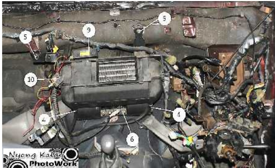
Gambar 3.4 Cooling unit bagian dalam
