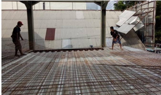
Gambar 5.45 Pemasangan Wiremesh dan Plat Bondek
