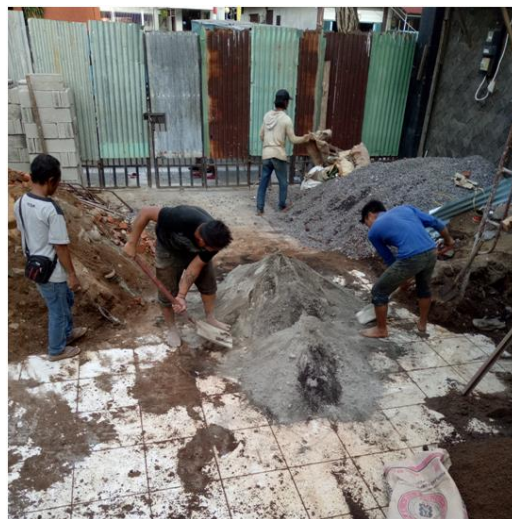
Gambar 5.34 Pembuatan Campuran Beton Pengecoran Pondasi
