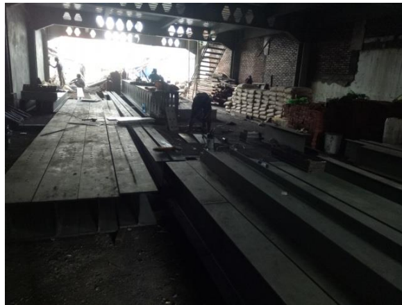
Gambar 5.38 Pembuatan Elemen Kolom Balok Baja (di lokasi proyek)
