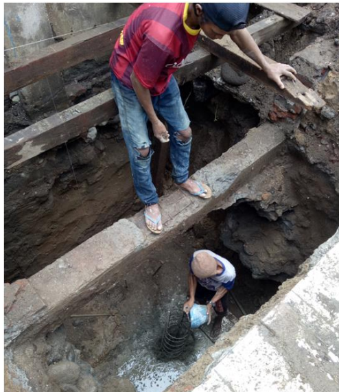
Gambar 5.36 Pemasukan Campuran Beton Kedalam Tiang Pondasi
