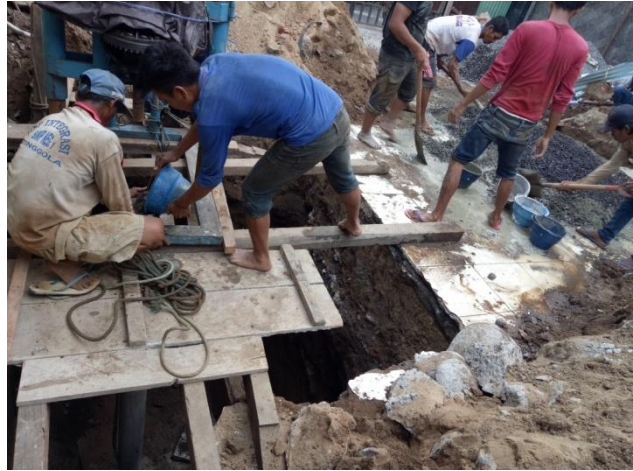
Gambar 5.35 Pengecoran Pondasi Secara Manual
