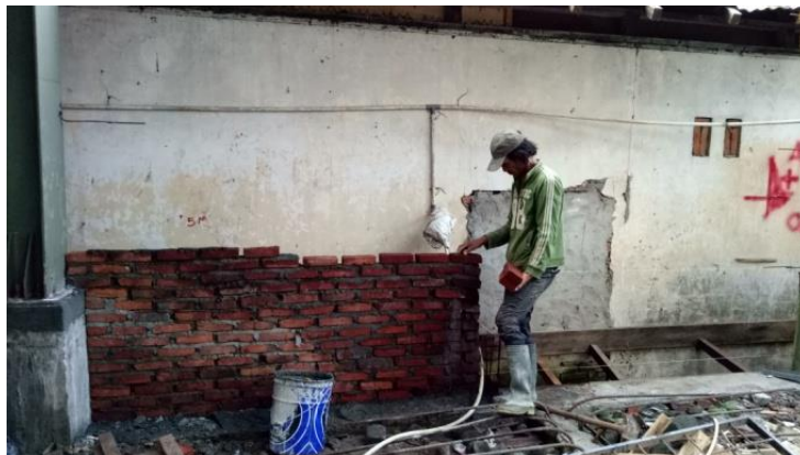
Gambar 5.48 Pemasangan Dinding
