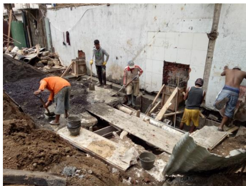
Gambar 5.37 Pengecoran Tiebeam/Sloof
