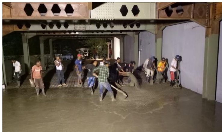
Gambar 5.47 Pengecoran Pelat Lantai Dua
