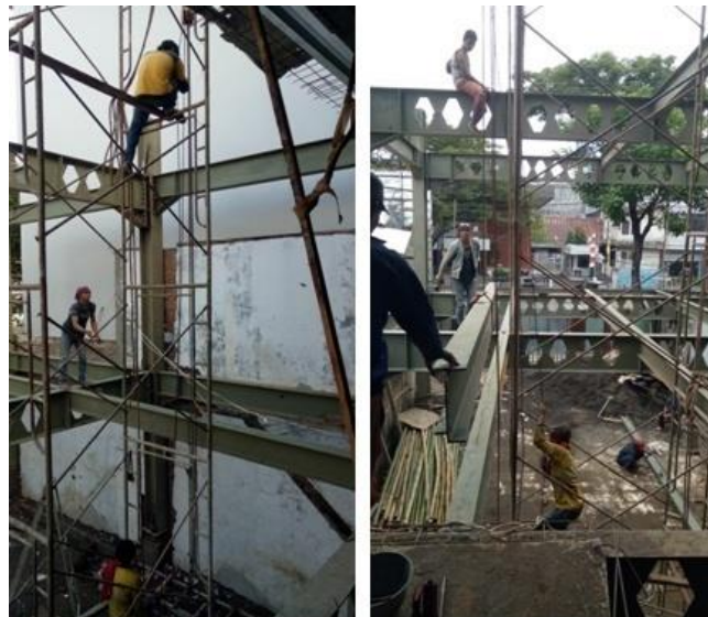
Gambar 5.43 Erection (pengangkatan) Kolom dan Balok
