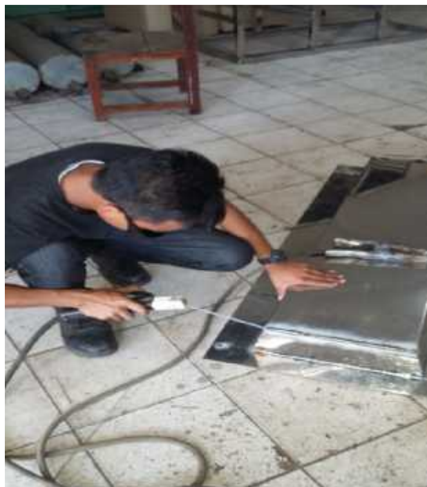
Lampiran 12. Mengelas tempat saluran uap panas
