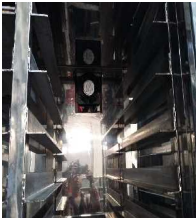
Lampiran 22. Pemasangan kipas (fan) pada dinding belakang proofer
