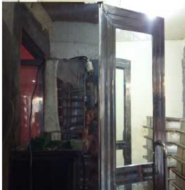
Lampiran 20. Pemasangan saklar
