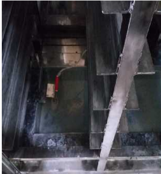
Lampiran 21. Pemasangan heater pada bak penampungan air
