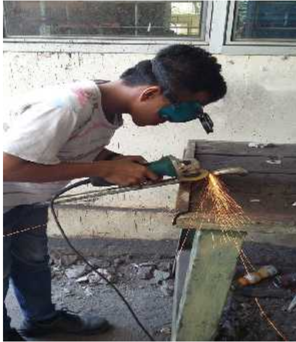
Lampiran 13. Menggrinda pipa saluran pembuangan uap panas
