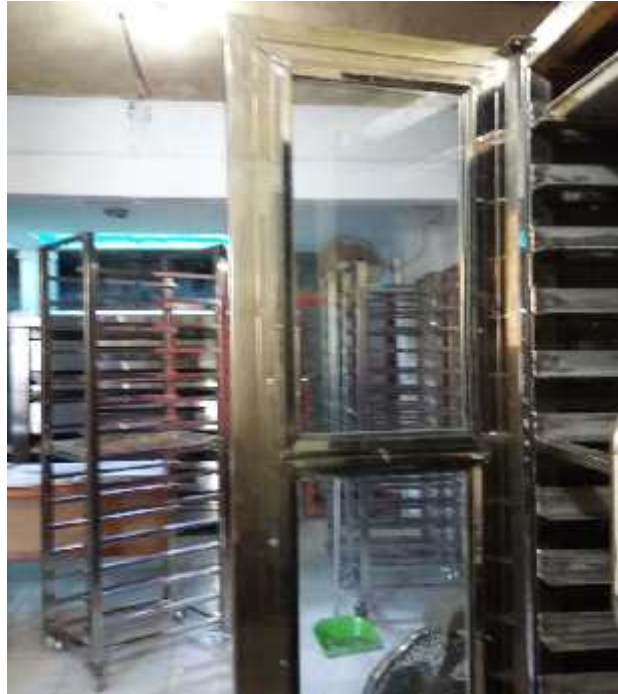
Lampiran 19. Pemasangan kaca pada bingkai pintu
