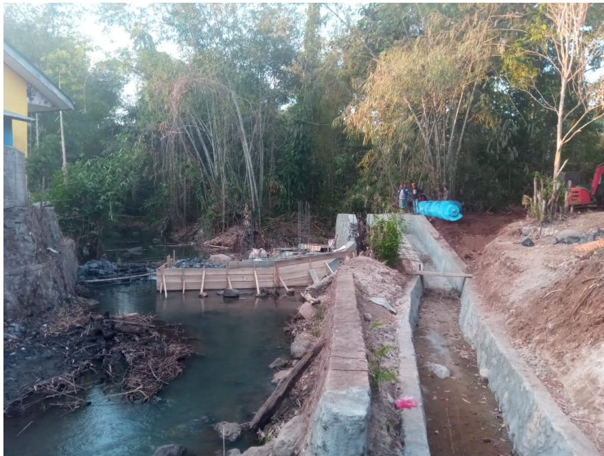
Gambar.Foto Pembuatan Bendungan dan saluran
