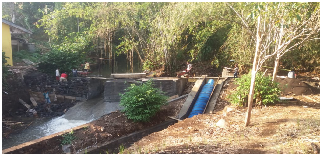
Gambar. PLTMH Turbin ulir Archimedes
