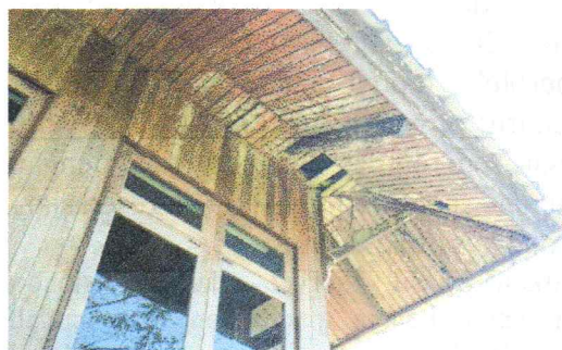
Gambar 5. Kerusakan kayu kelapa akibat lumut di Kemboan Rurukan Minahasa. Sumber: Makalew 2015
