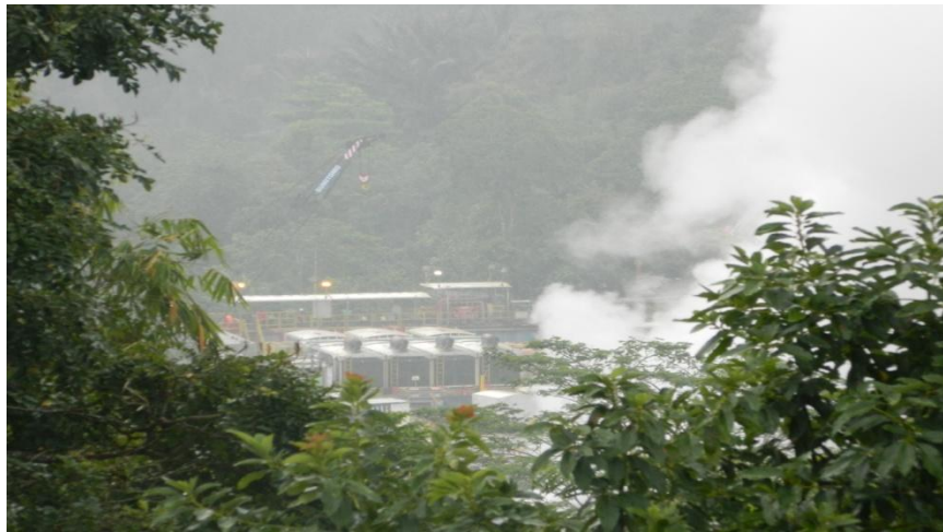
Gambar 2.5 Sumur Bor PLTP Lahendong Unit 1 Cluster 13.
