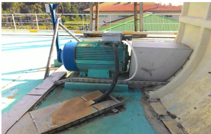
Gambar 2.25 Motor Fan Cooling Tower
