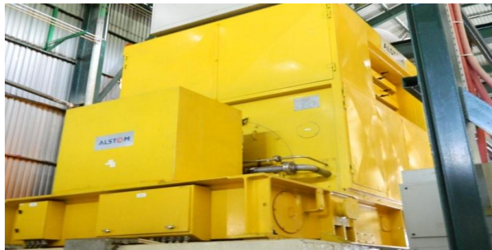
Gambar 2.11 Generator Unit 1 PLTP Lahendong
