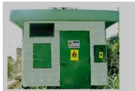
Gambar 3.2 gardu beton
