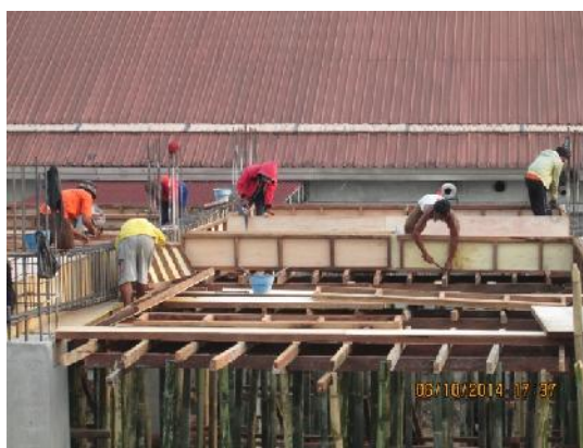
Gambar 3.64 Pemasangan bekisting balok dan plat
