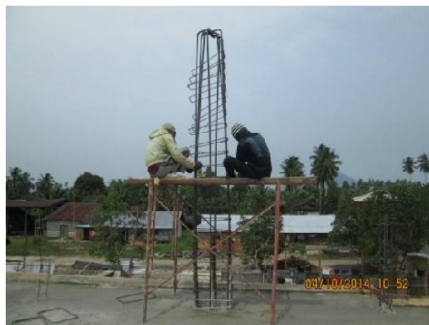
Gambar 3.62 Perakitan tulangan kolom
