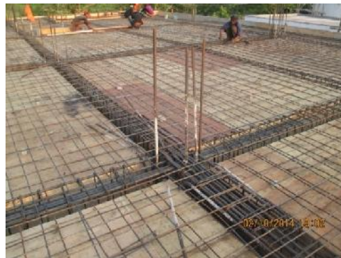
Gambar 3.65 Pembesian balok dan plat lantai
