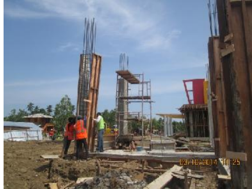
Gambar 3.63 pemasangan bekisting kolom
