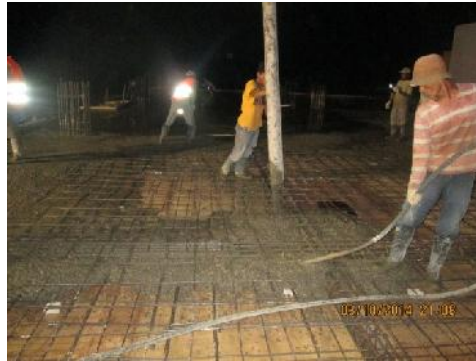
Gambar 3.66 Pengecoran balok dan plat lantai
