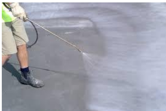
Gambar 3.67 Perawatan beton
