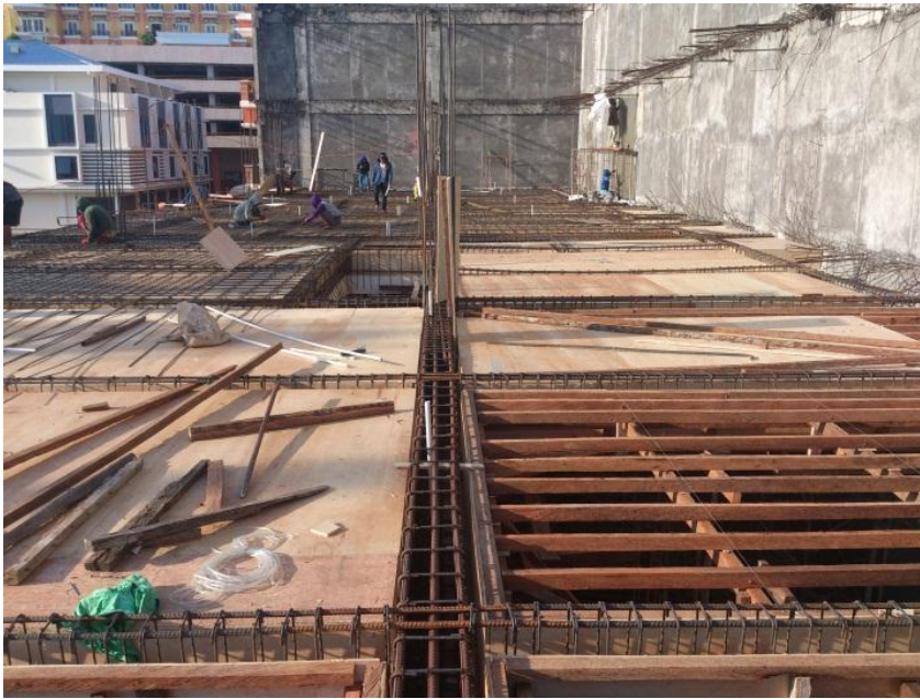
Gambar 3.13 Bekisting Pelat
