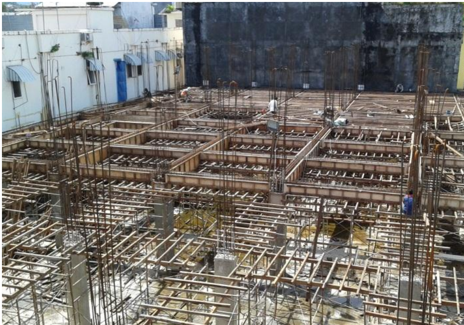
Gambar 3.11 Pekerjaan Balok Dan Pelat
