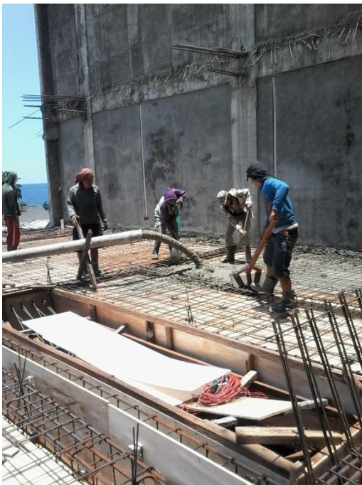
Gambar 3.16 Pengecoran Balok dan Pelat
