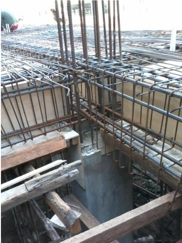
Gambar 3.14 Pembesian Balok
