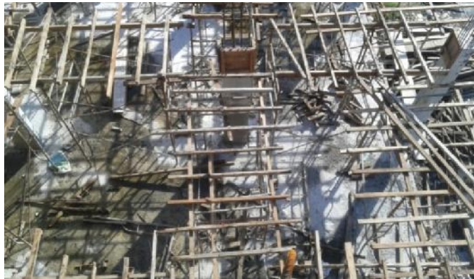
Gambar 3.57 Proses Pemasangan Girder
