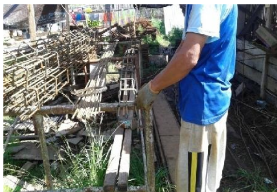
Gambar 3.55 Proses Rangkaian Tulangan
