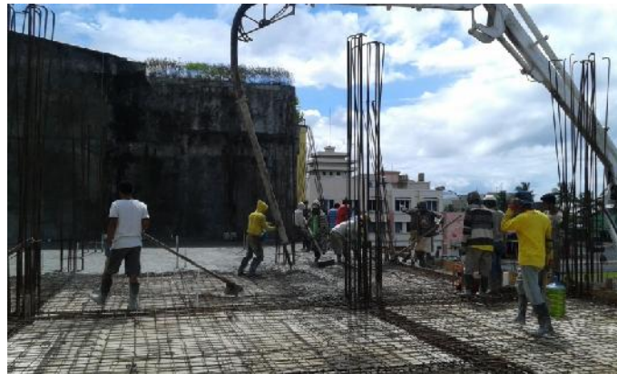
Gambar 3.58 Pengecoran balok dan pelat lantai.
