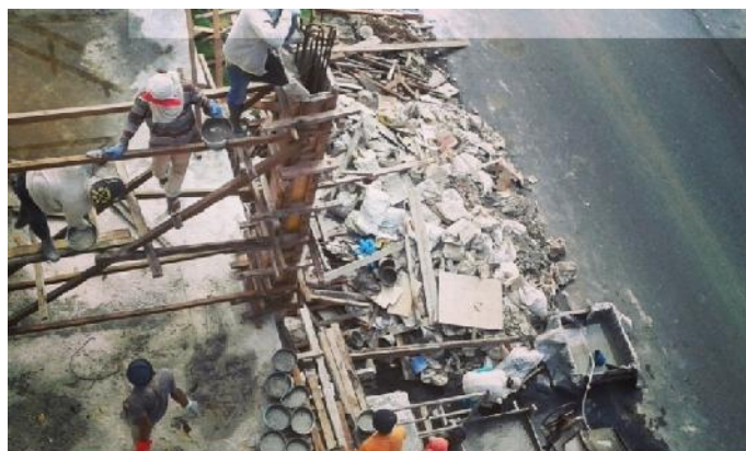
Gambar 3.56 Proses Pengecoran Tiang Kolom
