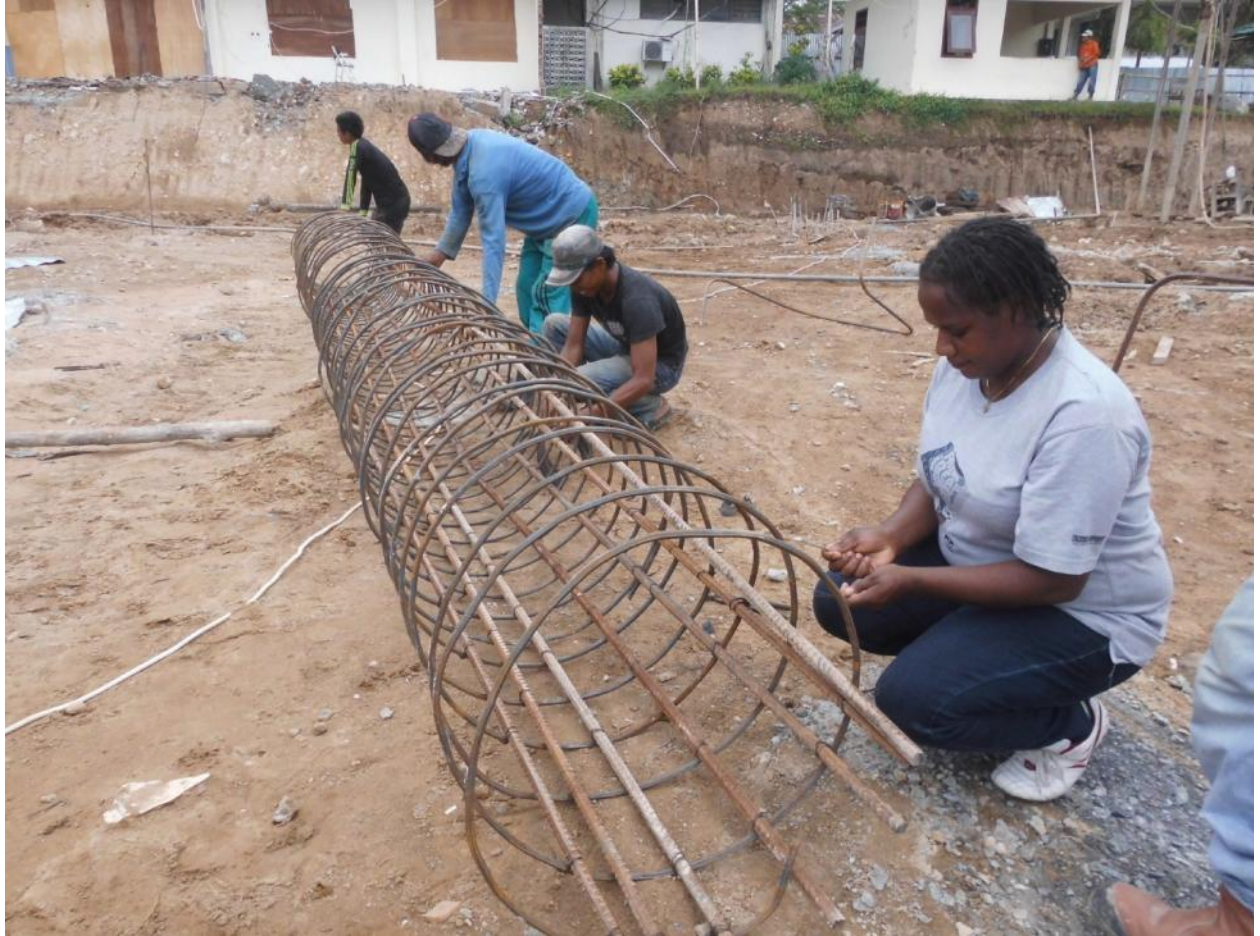
Pekerjaan mengikat tali bendrat pada tulangan kolom
