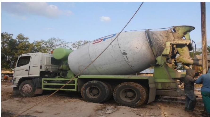
Gambar 1.3 Alat Gradimix ,Pekerjaan Pengecoran Pondasi Bor File
