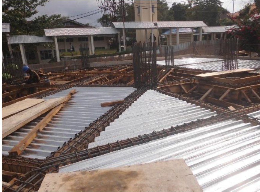
Gambar 1.2 Pekerjaan Kolom Dan Plat Lantai
