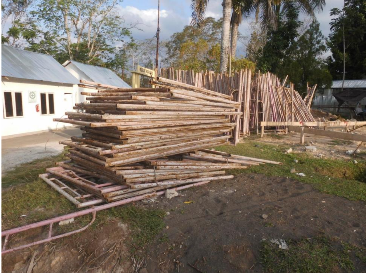
Skafolding berada pada lokasi kerja
