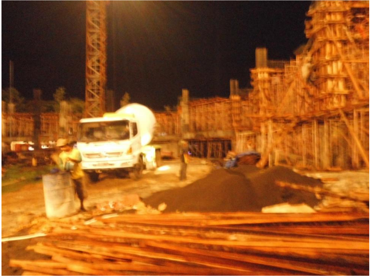
Pekerjaan cor kolom dan balok
