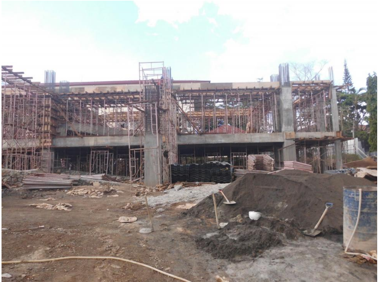
Pekerjaan balok dan kolom
