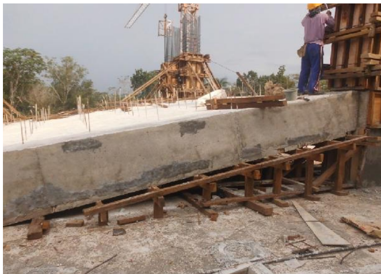
Gambar 1.1 Pemasangan Bowflan Pada Balok Dan Kolom
