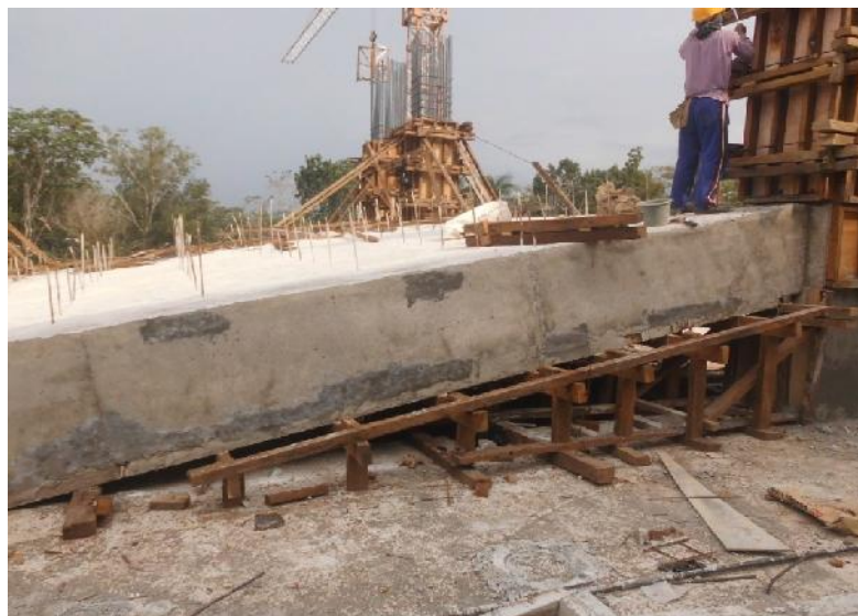
Gambar 1.1 Pemasangan Bowflan Pada Balok Dan Kolom
