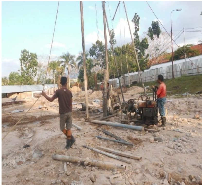
Gambar 1.6 Pekerjaan Bor File
