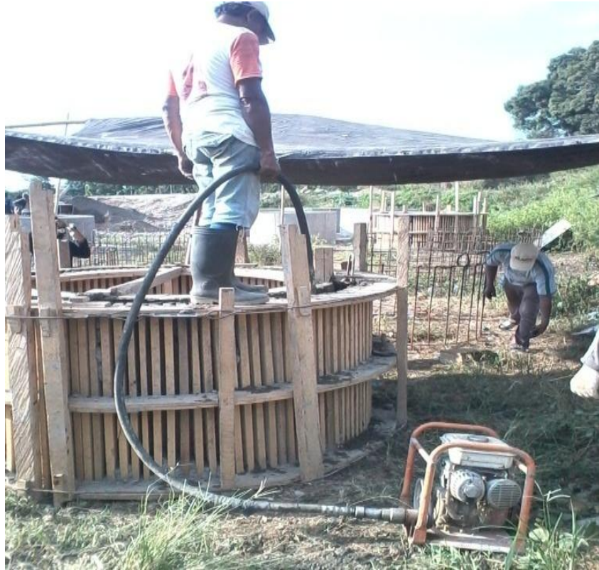
Sumber: PT.Waskita Karya Proyek, Pembangunan Jaringan Irigasi D.I Sangkub kiri P-31
