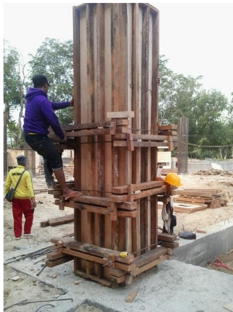
Gambar 3.29 Pemasangan bekisting kolom
