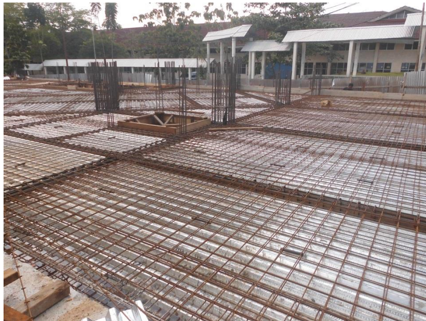
Gambar 3.33 Pemasangan bondek dan wire mesh
