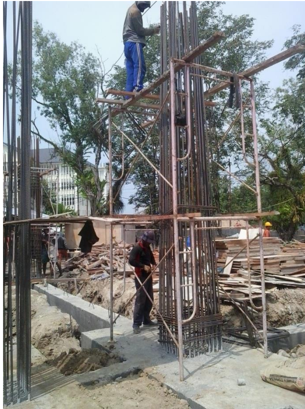
Gambar 3.28 Perakitan tulangan Kolom
