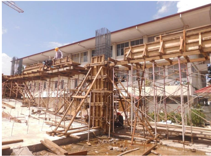
Gambar 3.31 Pemasangan Bekisting balok
