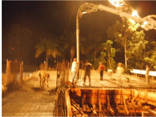
Gambar 3.35 Pengecoran dengan menggunakan concrete pump
