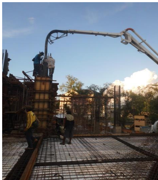
Gambar 3.30 Pengecoran Kolom di lantai Dasar
