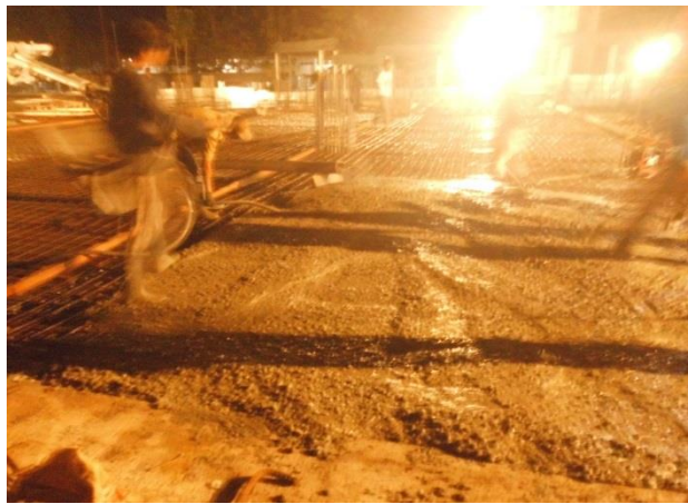
Gambar3.34 Proses pengecoran pelat lantai
