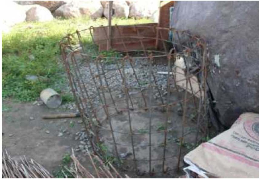
Lampiran 3 Pembesian Pada Buis Segi Delapan
