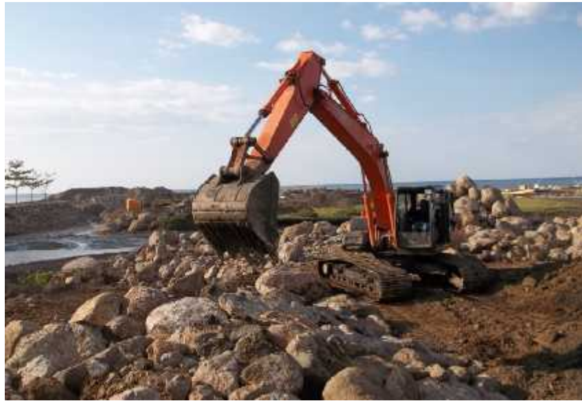
Lampiran 5 Pemasangan Batu Boulder
