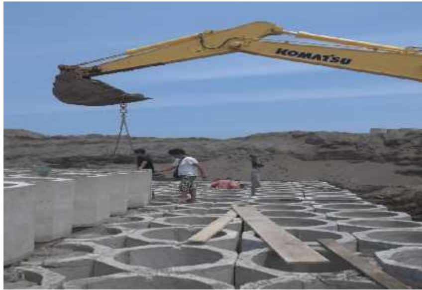
Lampiran 7 Pemasagan Buis Beton Segi Delapan
