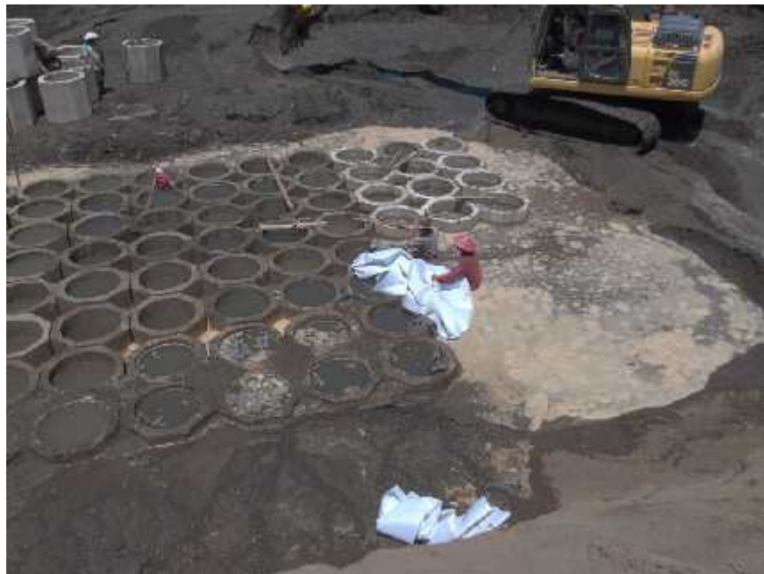
Lampiran 6 Pemasangan Geotextile
