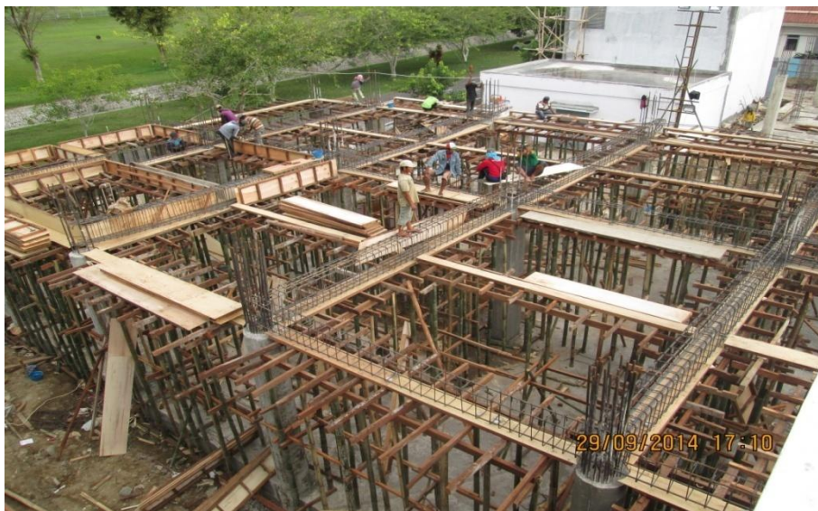
Gambar 3.10 pemasangan bekisting balok dan plat lantai.
