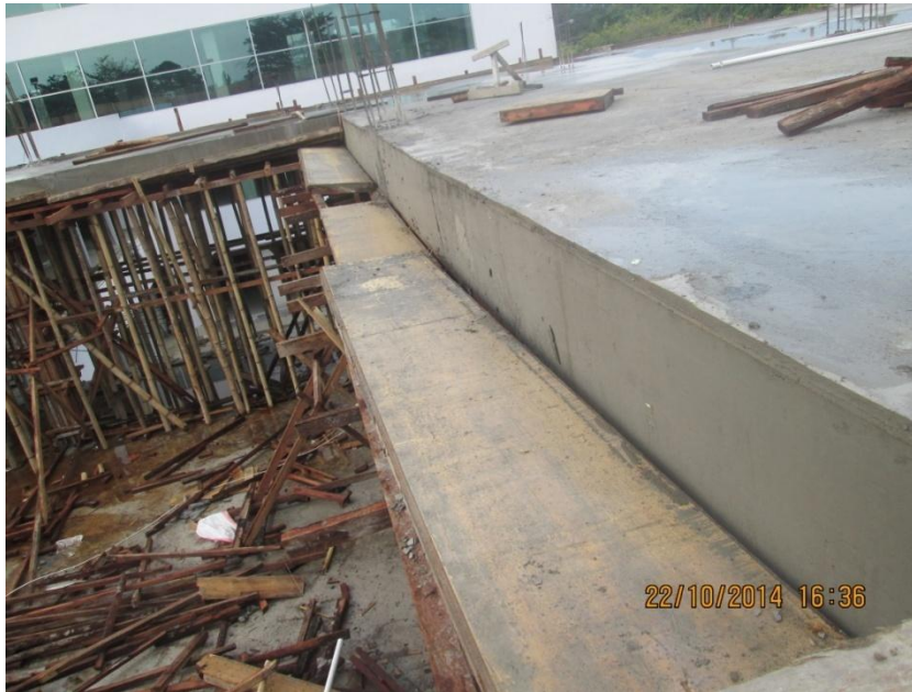
Gambar 3.13 pembongkaran bekisting
