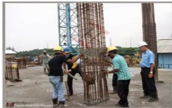
Gambar 2.7 pembesian kolom
