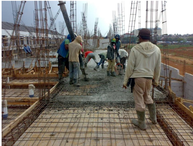
Gambar 2.10 pengecoran plat lantai dan balok.
