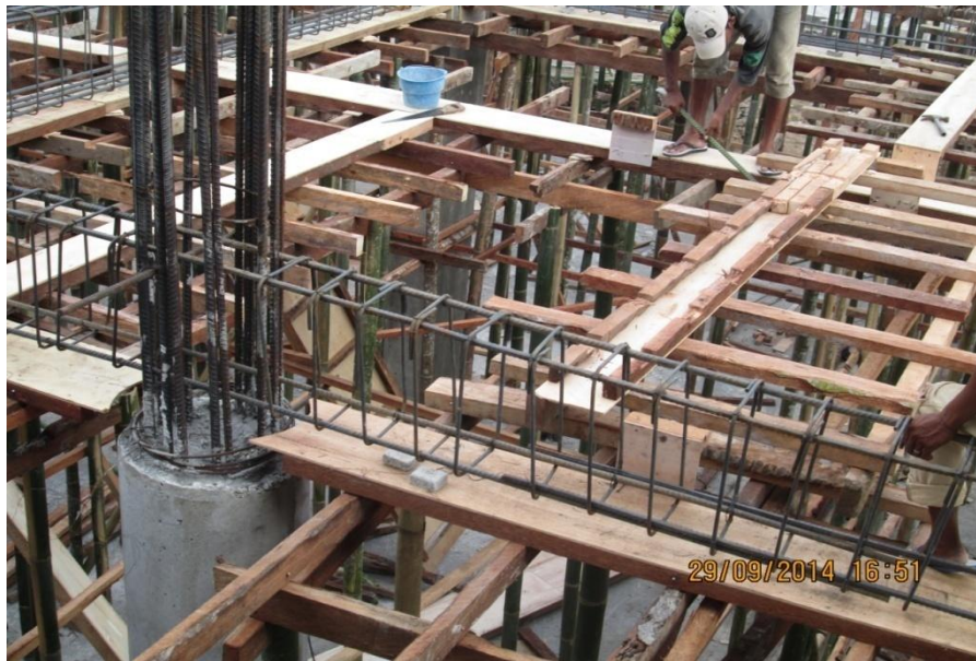
Gambar 3.9 Pemasangan bekisting pada balok.
