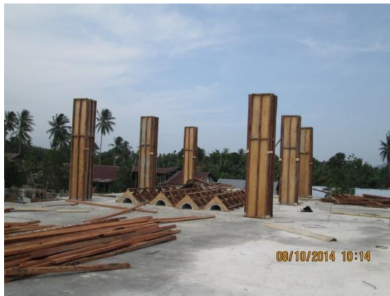
Gambar 2.7 pemasangan bekisting kolom.
