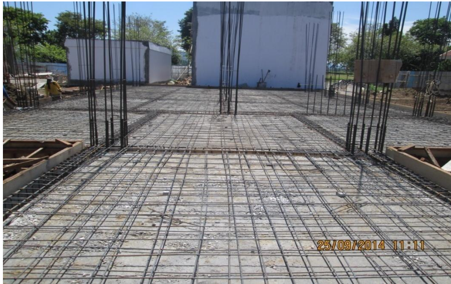
Gambar 3.11 Pemasangan pembesian pada balok dan pelat
