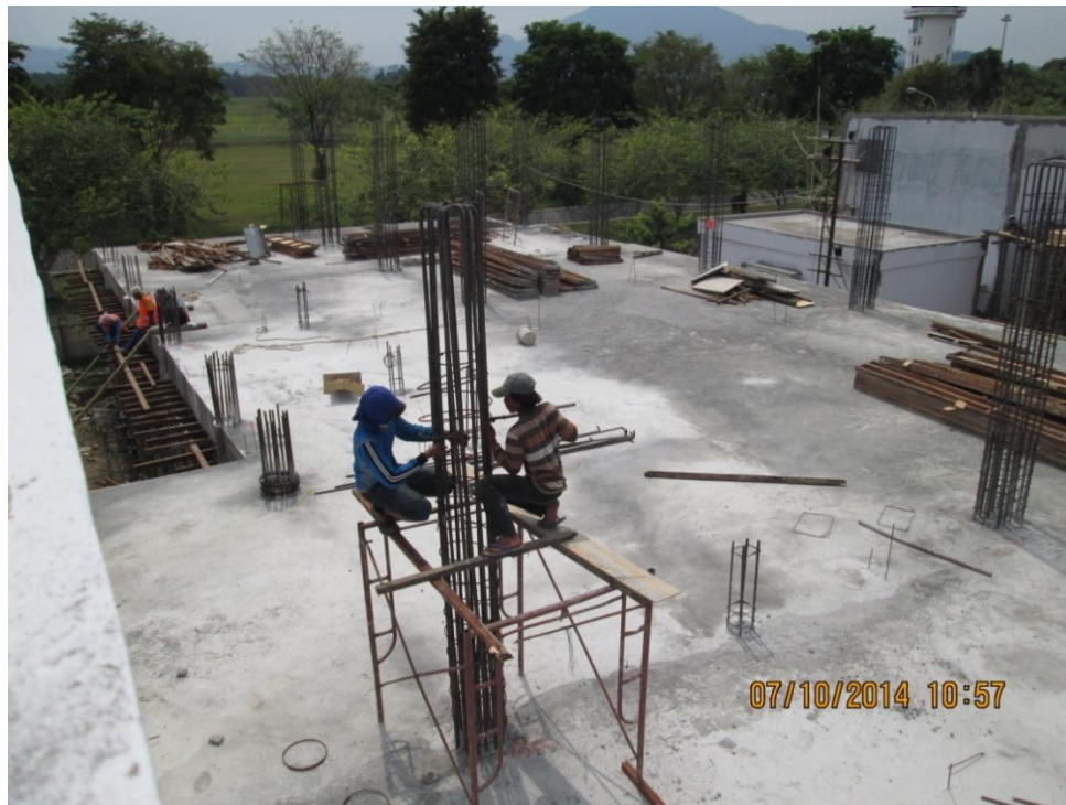
Gambar 3.6 pemasangan sengkang pada kolom
