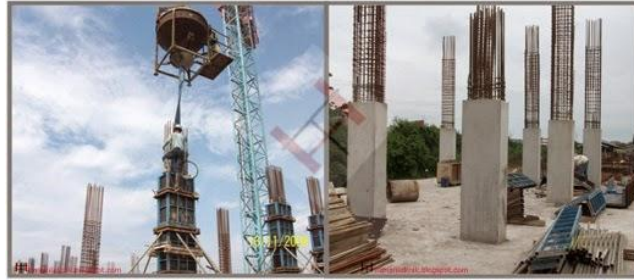
Gambar 2.9 pengecoran kolom
