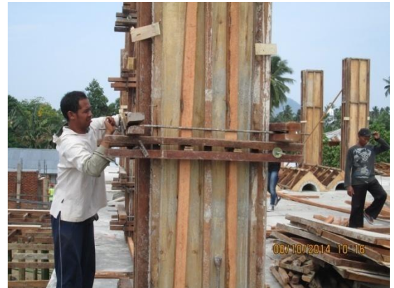
Gambar 2.7 pemasangan bekisting kolom.
