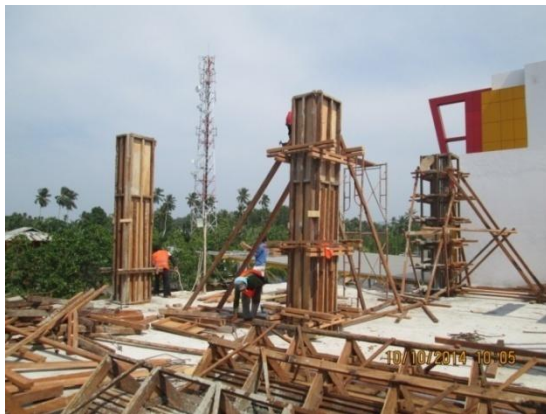
Gambar 3.8 pembongkaran bekisting kolom.
