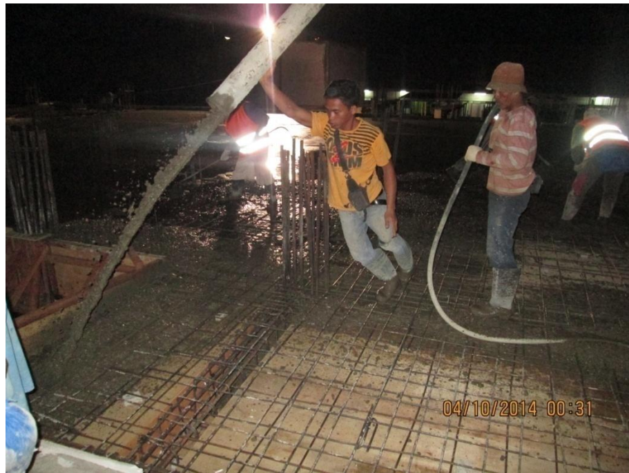
Gambar 3.12 pengecoran balok dan plat lantai
