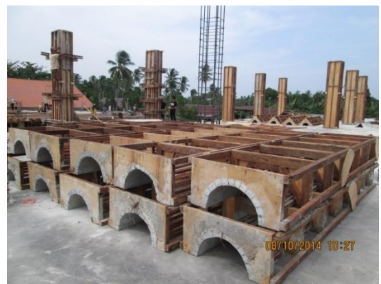
Gambar 3.8 pembongkaran bekisting kolom.
