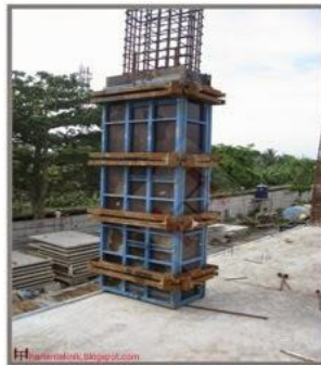
Gambar 2.8 pemasangan bekisting kolom
