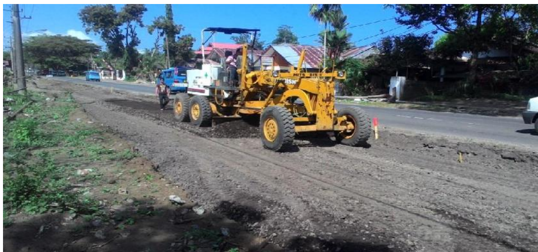
Gambar 2.9 Penghamparan Material Lapis Pondasi Bawah
