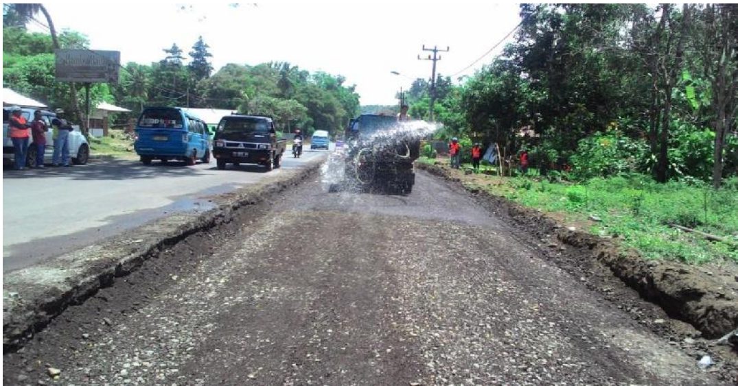
Gambar 2.11 Penyiraman Lapis Pondasi Bawah
