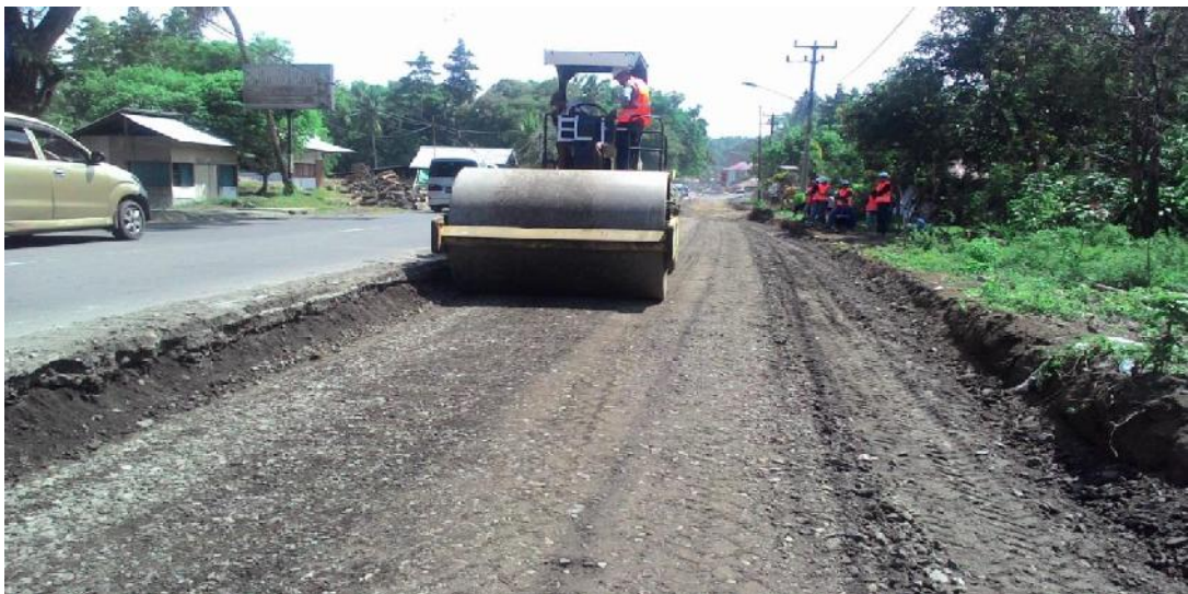
Gambar 2.12 Pemadatan Kembali Setelah Penyiraman.
