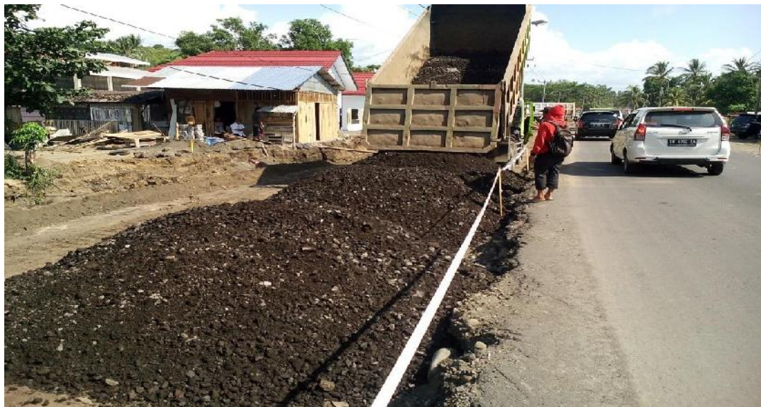
Gambar 2.8 Penuangan Material Lapis Pondasi Bawah
