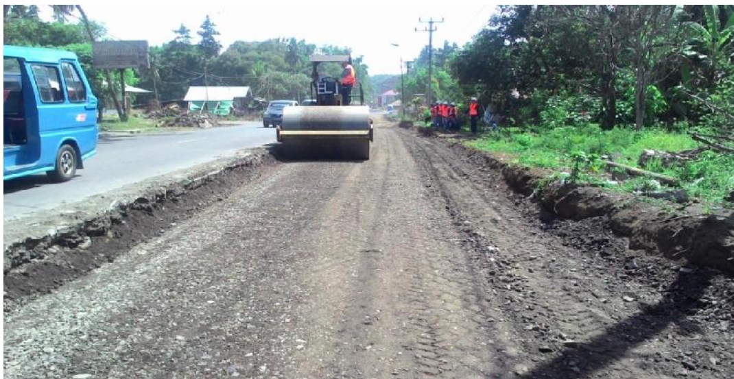
Gambar 2.10 Pemadatan Lapis Pondasi Bawah
