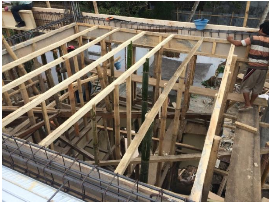
Gambar 64 Pemasangan Gelagar Penahan Bondek
