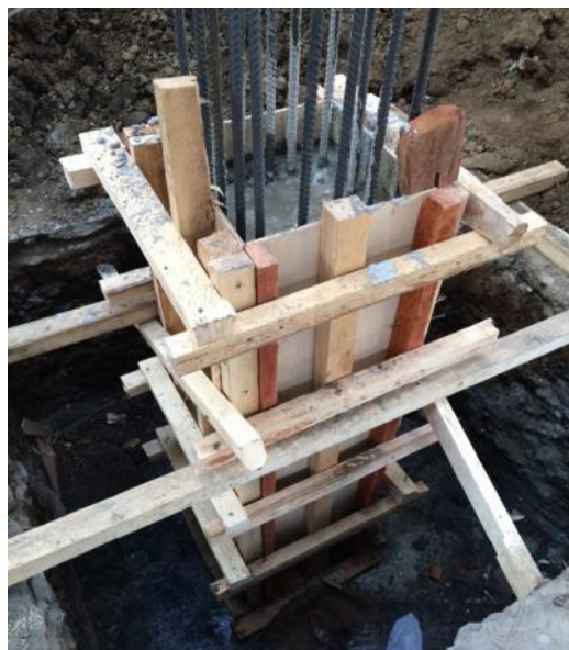
Gambar 53 Pengecoran Kaki Kolom
