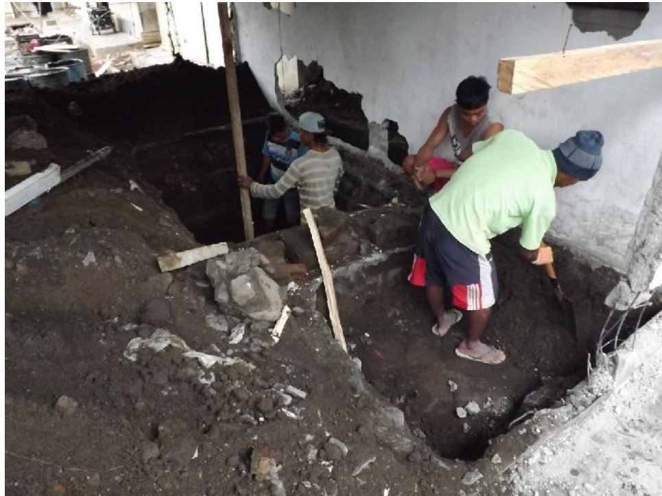
Gambar 48 Penggalian Tanah Pondasi Telapak
