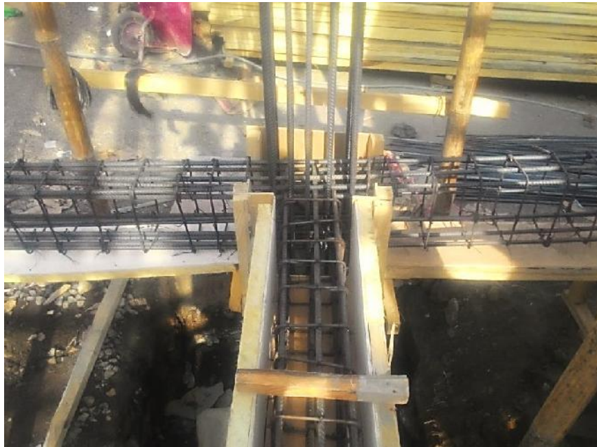
Gambar 55 Pemasangan Tulangan Sloof
