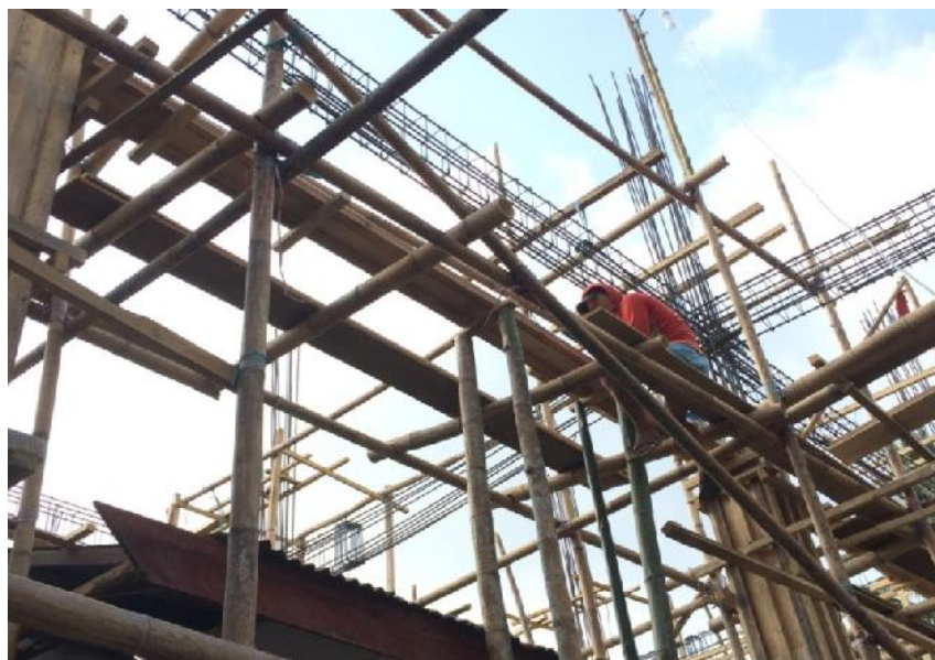
Gambar 59 Pemasangan Bekisting Balok
