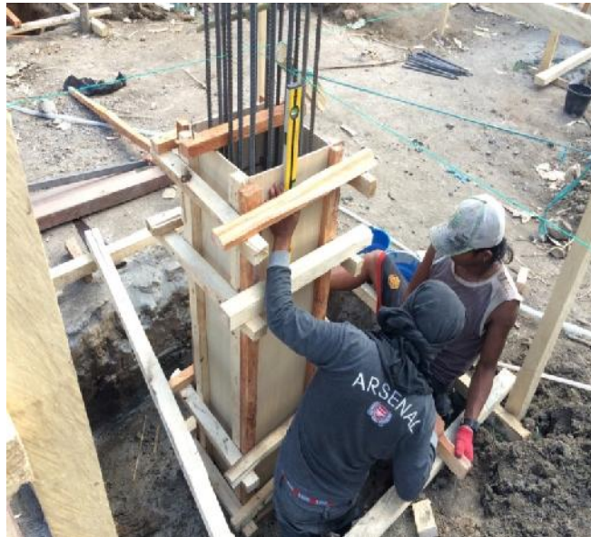
Gambar 52 Pemasangan Bekisting Kaki Kolom
