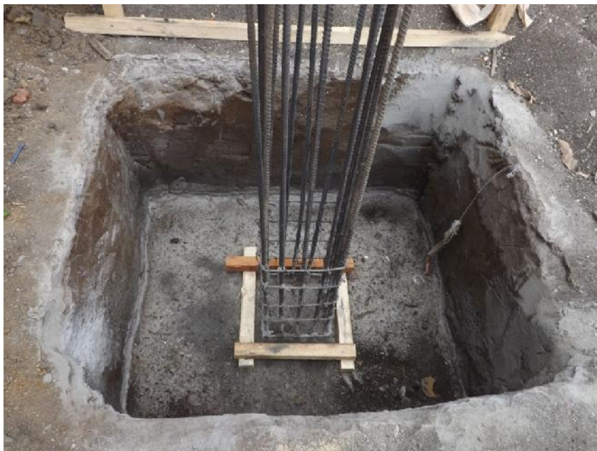
Gambar 51 Pengecoran Pondasi Telapak
