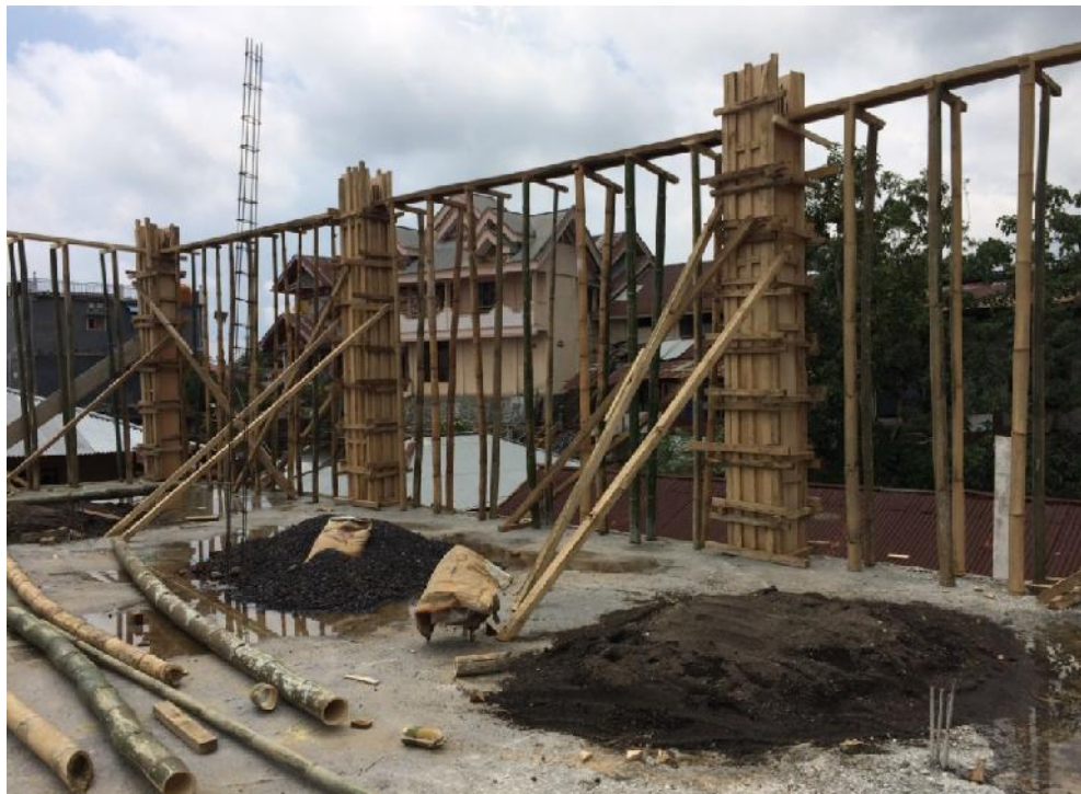
Gambar 68 Pembuatan Kolom dan Pemasangan Bekisting Ringbalok
