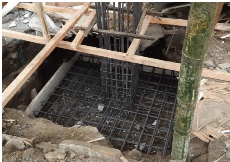
Gambar 50 Pemasangan Tulangan Pondasi Telapak & Tulangan Kolom
