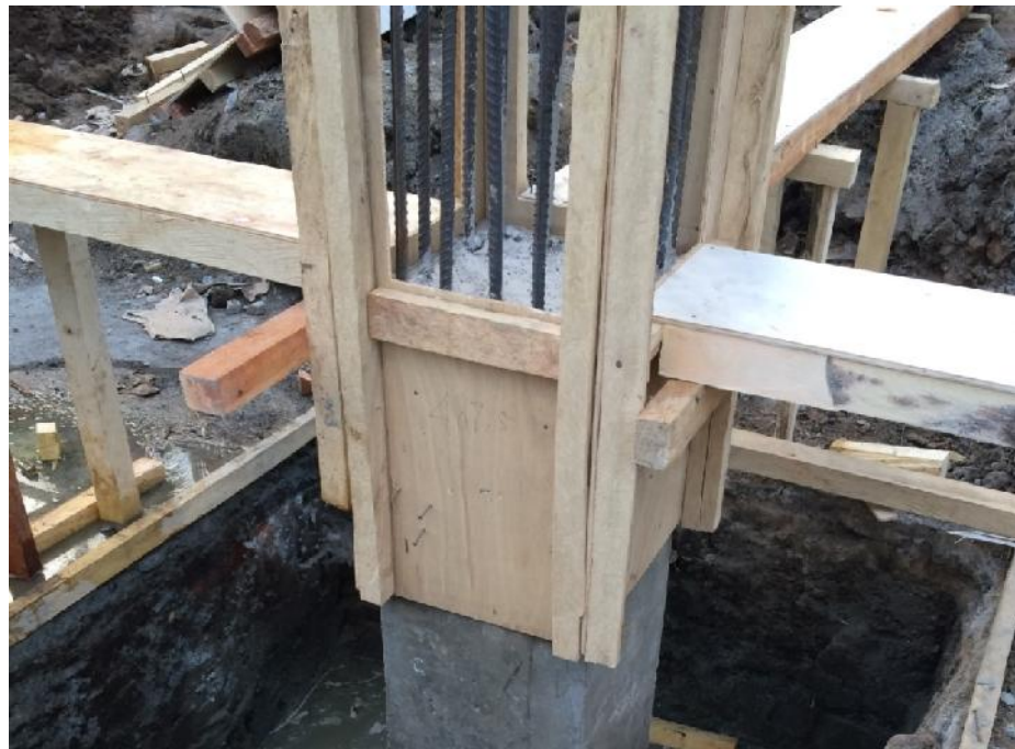
Gambar 54 Pemasangan Bekisting Sloof
