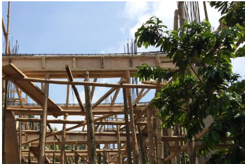
Gambar 69 Pengecoran Ringbalok
