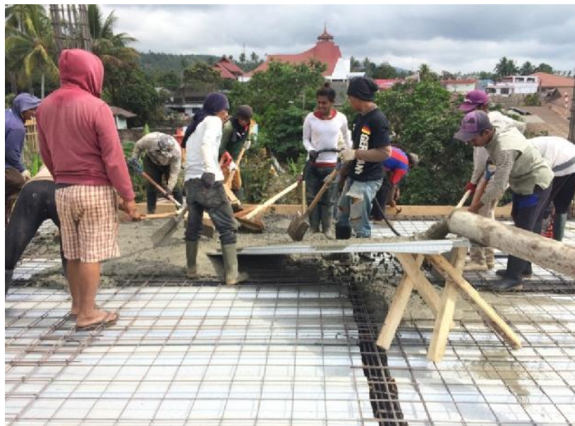
Gambar 67 Pengecoran Balok dan Pelat
