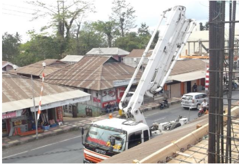
Gambar 66 Persiapan Pengecoran
