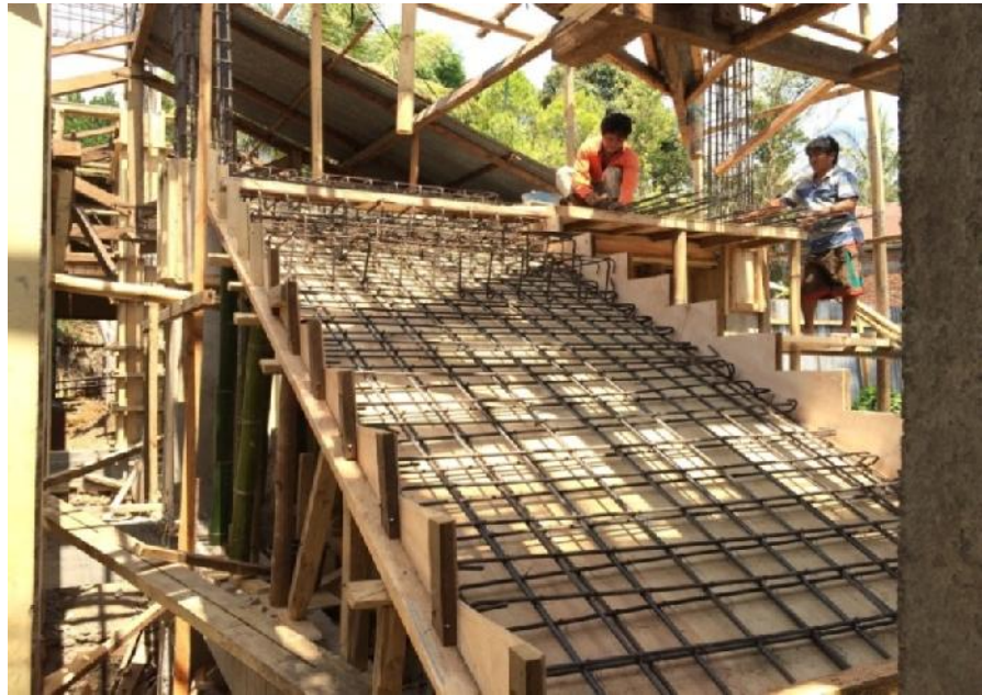
Gambar 61 Pemasangan Bekisting Tangga
