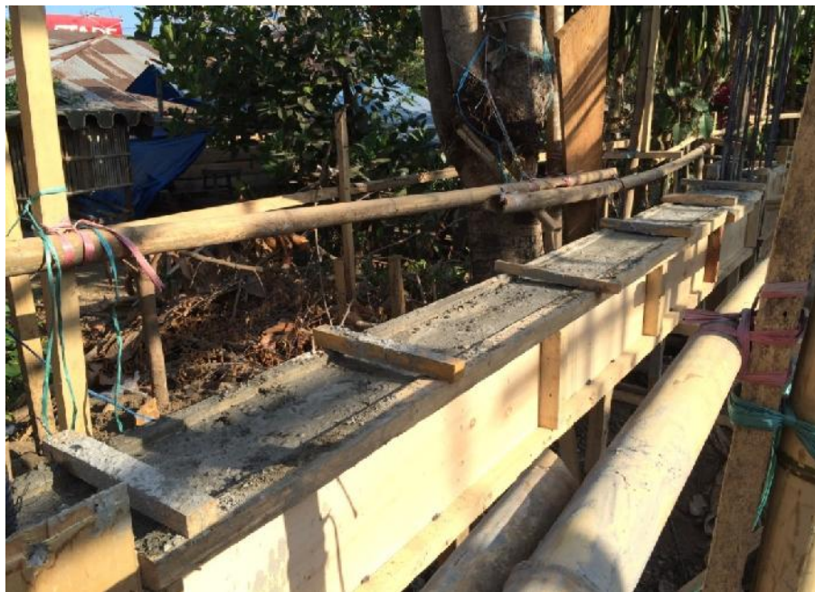
Gambar 56 Pengecoran Sloof
