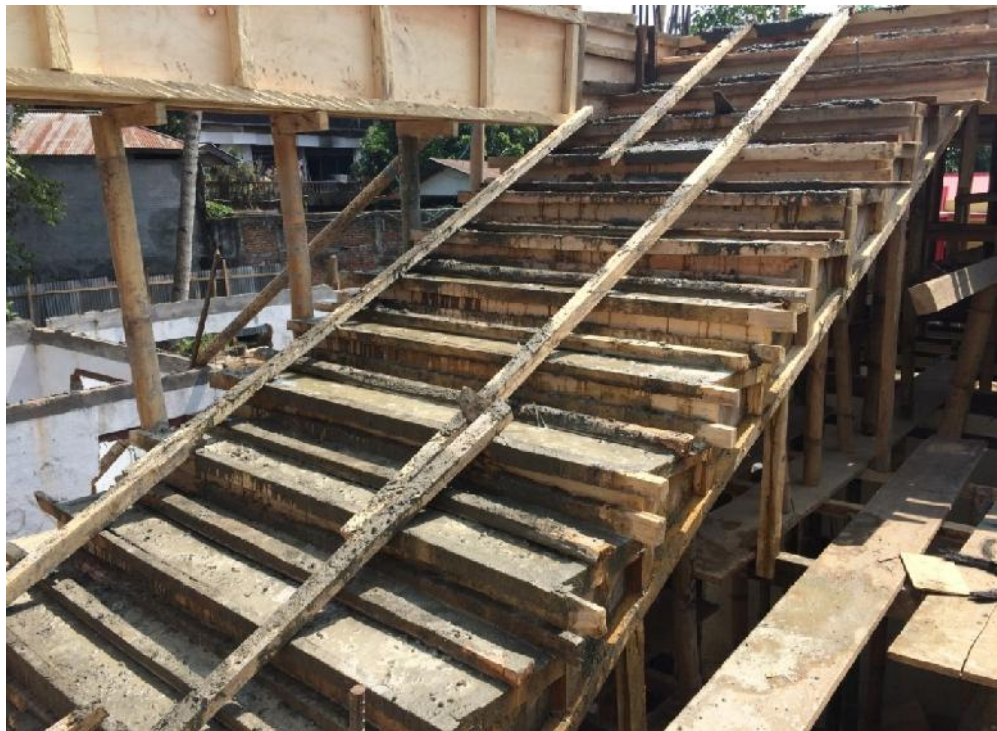
Gambar 63 Pengecoran Tangga
