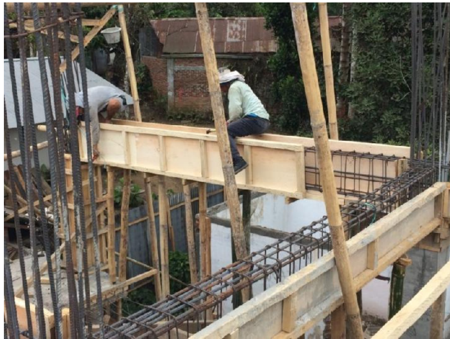
Gambar 60 Pemasangan Tulangan Balok
