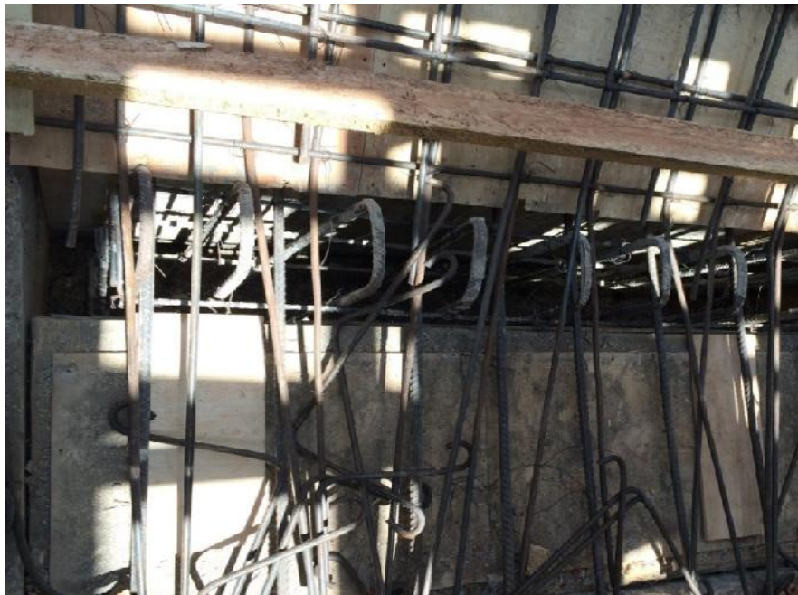
Gambar 62 Pembuatan Pondasi Tangga
