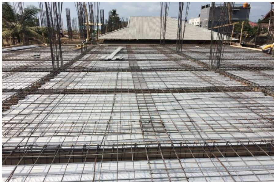
Gambar 65 Pemasangan Bondek dan Wiremess
