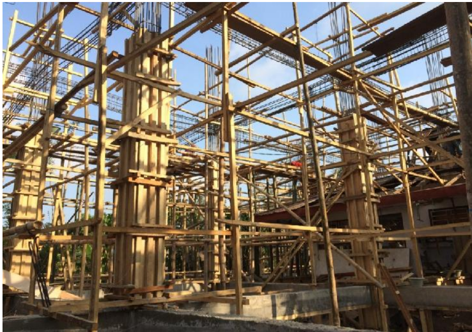
Gambar 57 Pemasangan Bekisting Kolom
