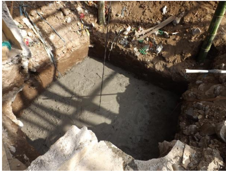
Gambar 49 Pengecoran Lantai Kerja Pondasi Telapak
