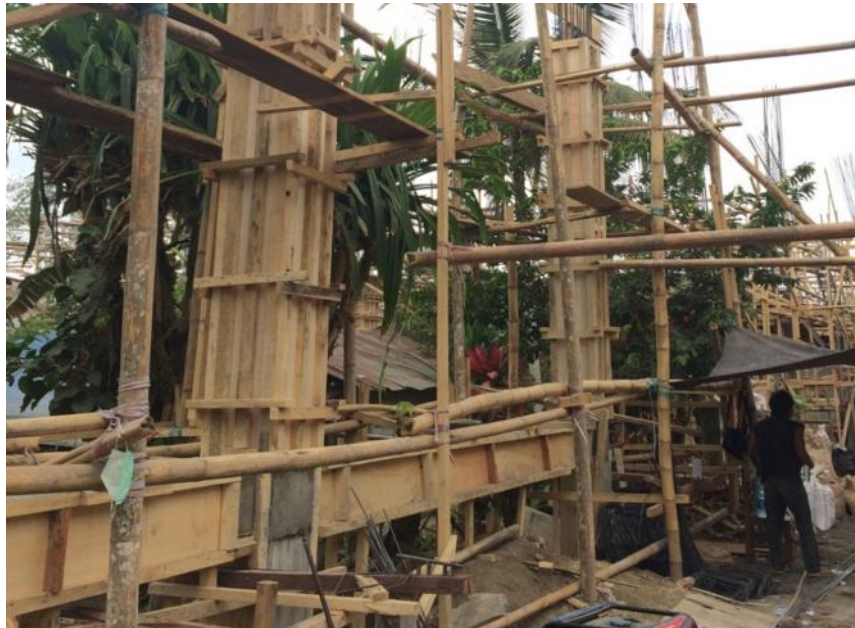
Gambar 58 Pengecoran Kolom
