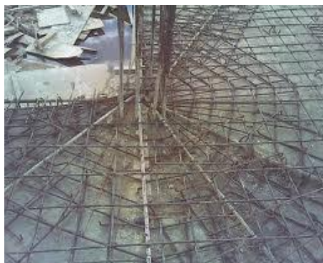
Gambar 2.4 Konstruksi Pondasi Sarang Laba-laba
