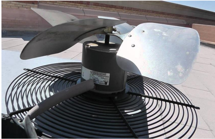
Gambar 15. Fan motor AC Central
