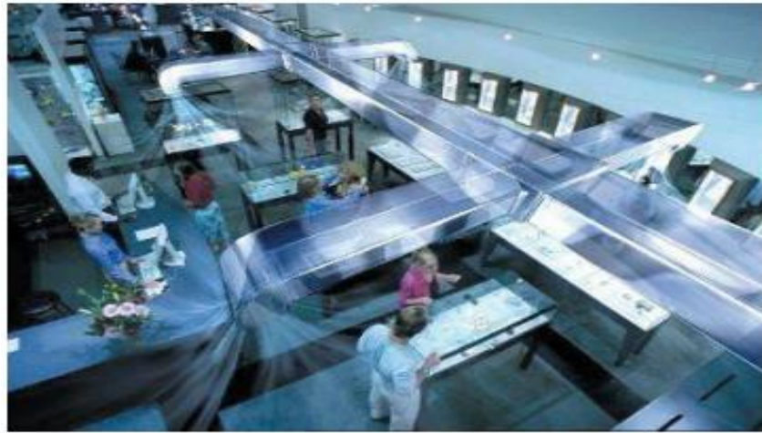
Gambar 3. Pemakaian AC Sentral pada Industri
