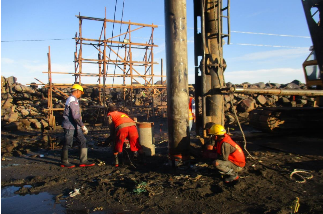
Gambar 4.21 Proses Penyambunga Tiang Dengan Pengelasan
