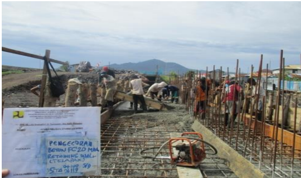
Gambar 4.3 Menunjukkan Pengecoran Retaining Wall
