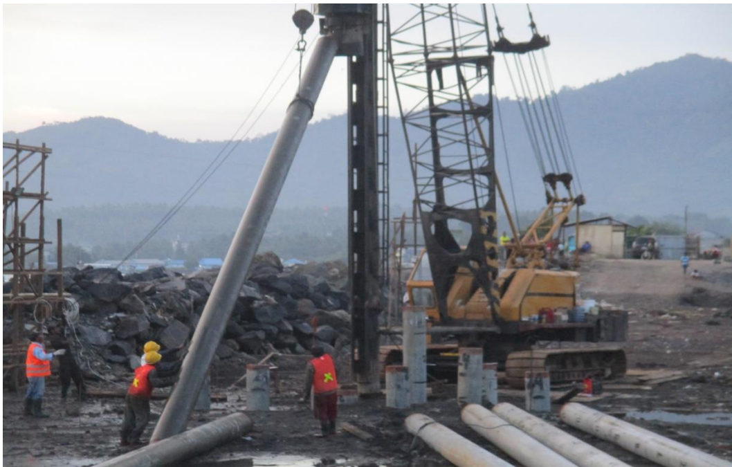
Gambar 4.19 Proses Pemasangan Tiang Pancang Kealat Tiang Pancang
