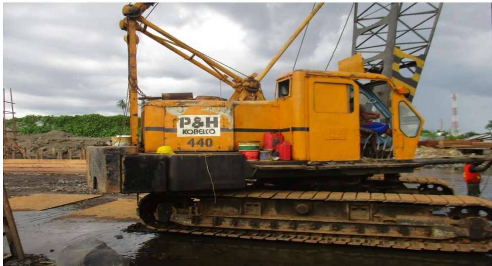
Gambar 4.16 Menunjukkan Proses Persiapan Alat Tiang Pancang
