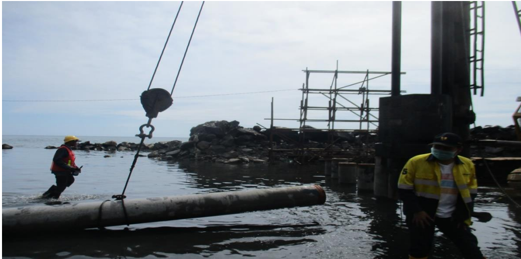
Gambar 4.18 Proses Pemasangan Tiang Kealat Tiang Pancang
