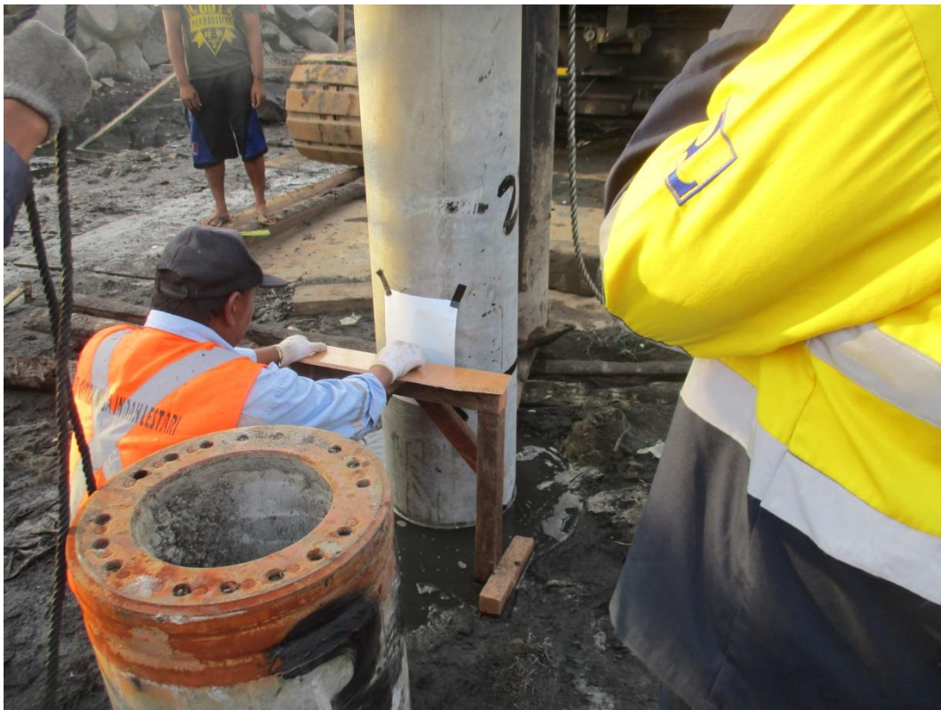
Gambar 4.23 Menunjukkan Proses Kalendring Pada Tiang Pancang
