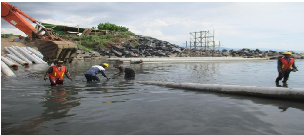
Gambar 4.17 Proses Pemberian identitas tiang dengan penomoran permeter
