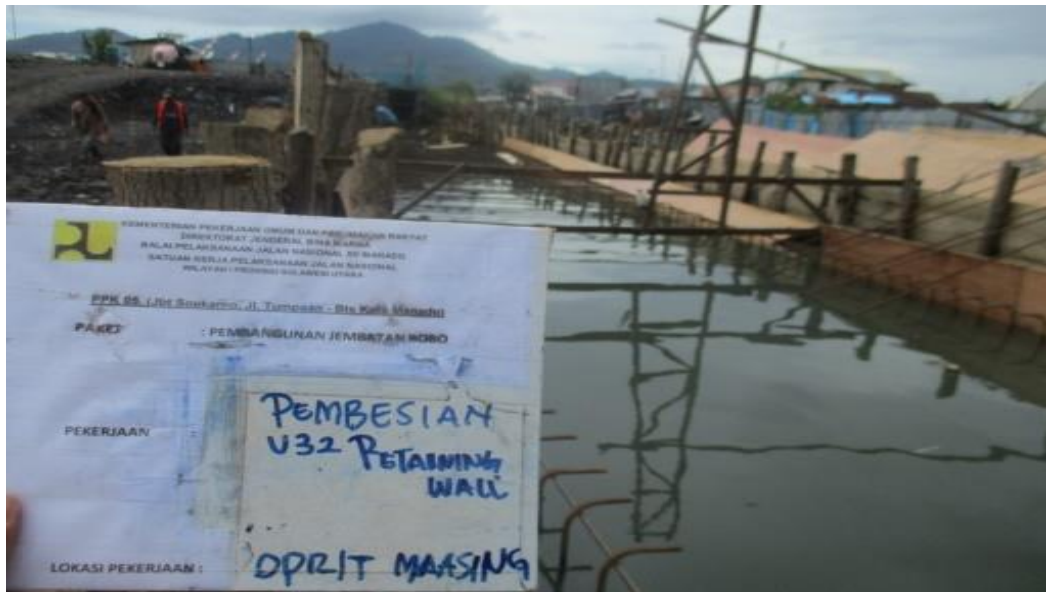
Gambar 4.2 Menunjukkan Pembesian Retaining Wall
