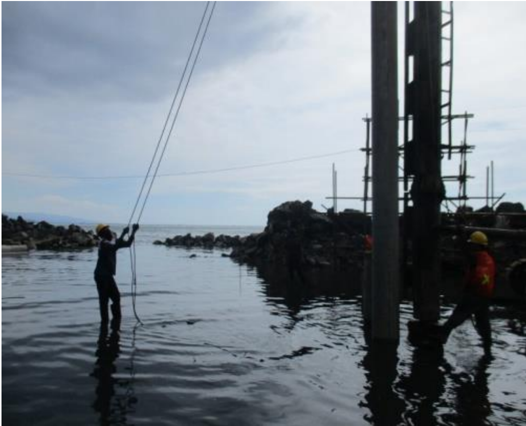
Gambar 4.1 Menunjukkan Pemasangan Tiang Pancang
