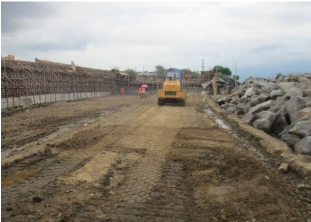
Gambar 4.4 Menunjukkan Proses Pemadatan Tanah
