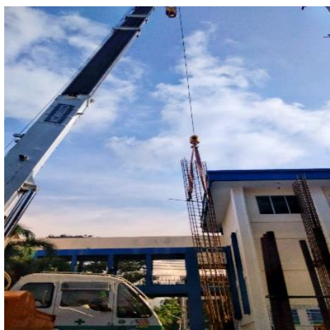
Gambar 5.5 Pengangkatan tulangan kolom dengan menggunakan mobile crane
