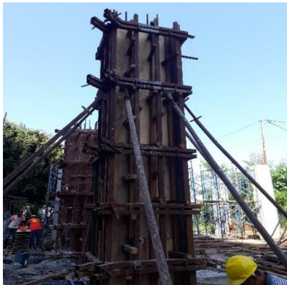
Gambar 5.7 Bekisting kolom pada proyek
