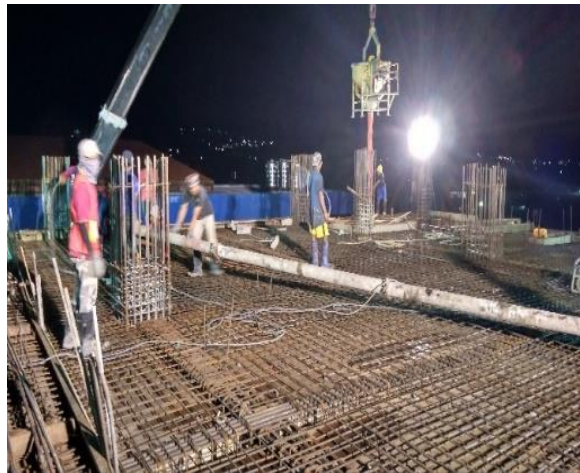
Gambar 5.18 Pengecoran balok dan pelat lantai
