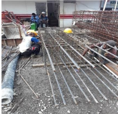
Gambar 5.4 Perakitan tulangan kolom
