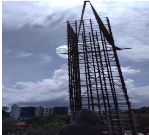
Gambar 5.6 Pemasangan tulangan kolom
