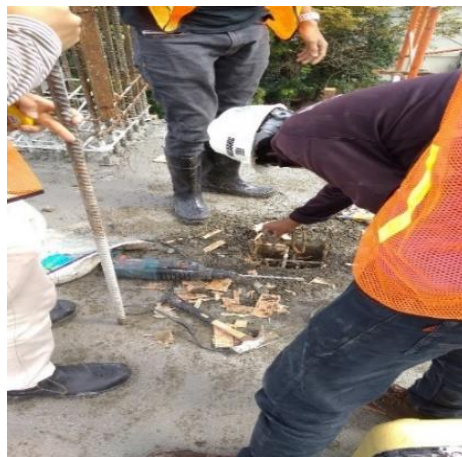
Gambar 5.1 Pembuatan lubang pada pelat lantai untuk menentukan as kolom
