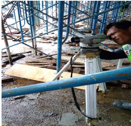
Gambar 5.16 Pengecekan elevasi balok dan pelat lantai
