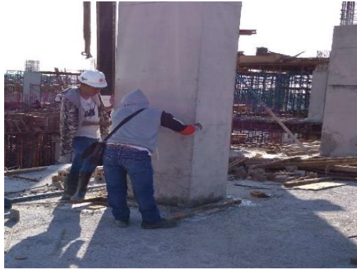
Gambar 5.11 Pembuatan marking elevasi pada kolom
