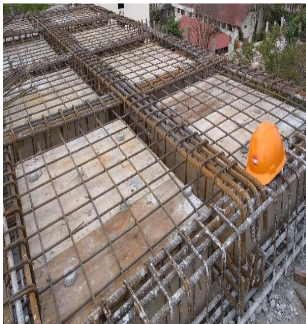
Gambar 5.13 Penulangan balok dan pelat lantai
