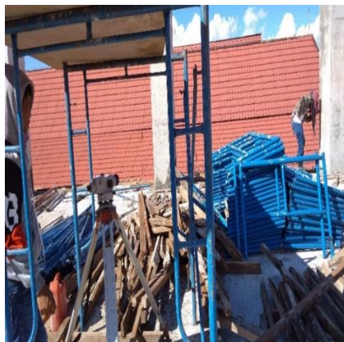
Gambar 5.10 Pembuatan titik elevasi pada kolom oleh suveyor
