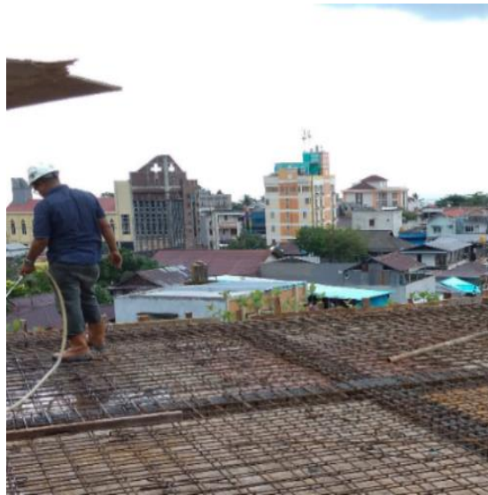
Gambar 5.17 Penyiraman area yang akan di cor
