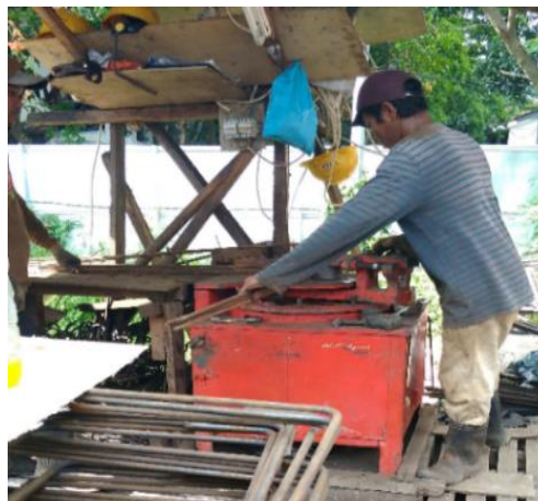
Gambar 5.3 Pembengkokan tulangan oleh pekerja pembesian
