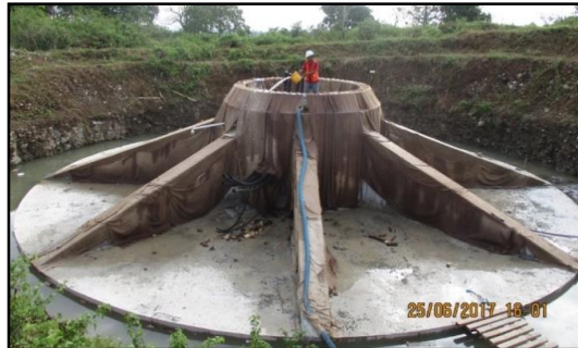
Gambar 2.2 Proses curing beton dengan menggunakan karung goni.
