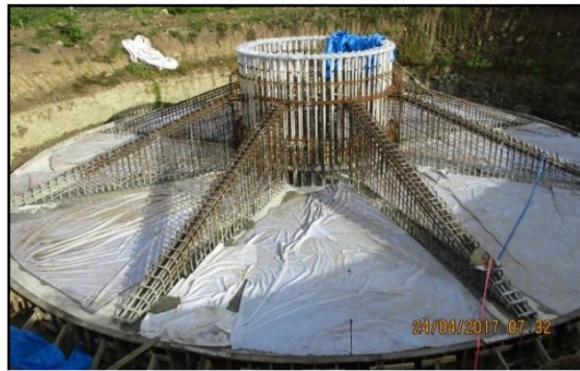
Gambar 2.3 Proses curing dengan menggunakan beton geotekstil
