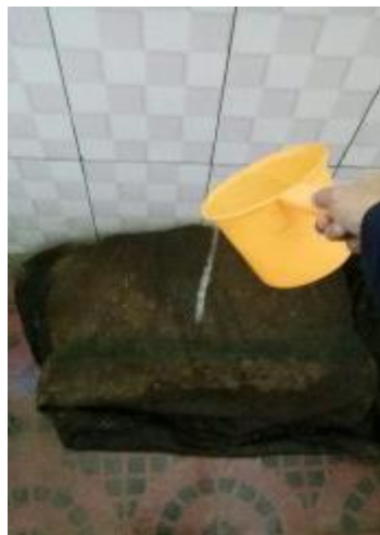
Gambar 3.28 Perawatan dengan cara ditutup menggunakan karung goni
