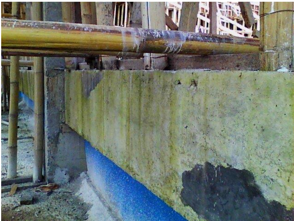
Gambar 4.5 Tampak balok bangunan Masjid Al-Muhajirin
