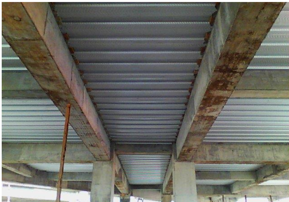
Gambar 4.10 Tampak kolom dan balok bangunan Pendidikan Terpadu Politeknik Negeri Manando
