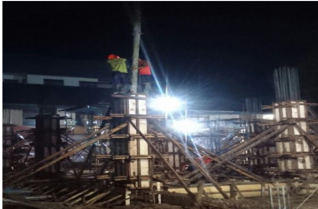
Gambar 4.26 Proses pengecoran kolom pada bangunan Puskesmas Paniki Bawah
