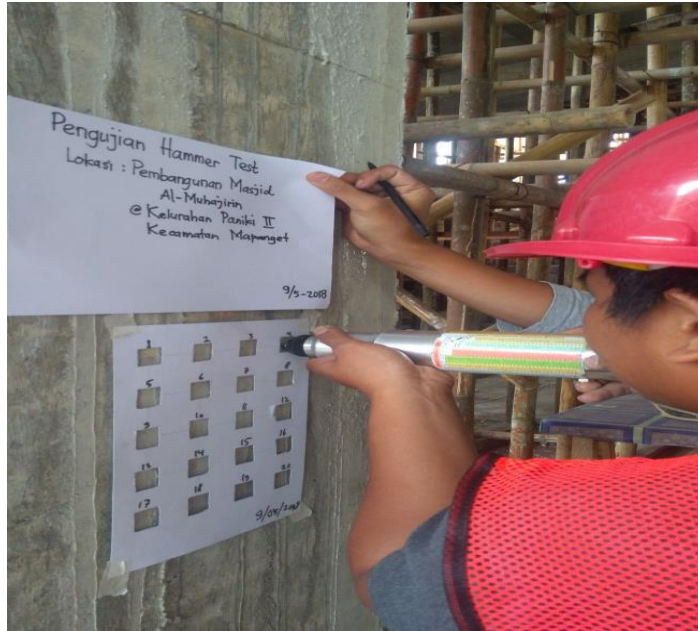
Pengujian Hammer Test pada kolom bangunan Masjid Al-Muhajirin
