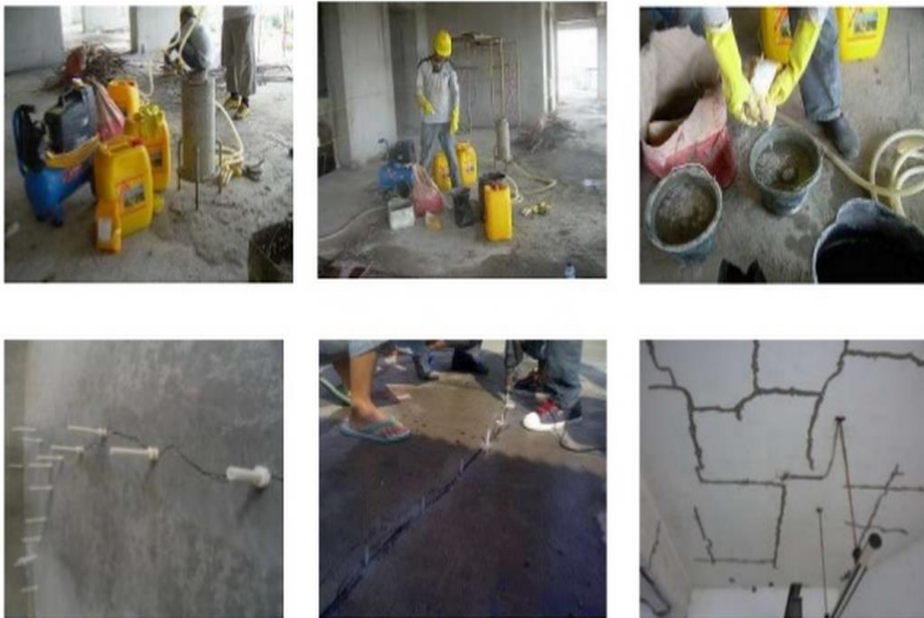
Gambar 4.25 Tahap-tahap Grouting
