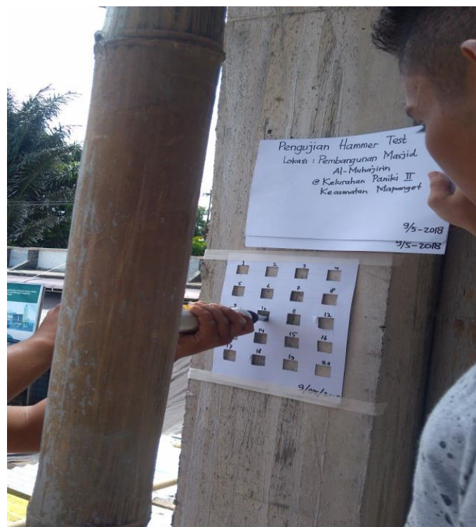
Pengujian Hammer Test pada kolom bangunan Masjid Al-Muhajirin
