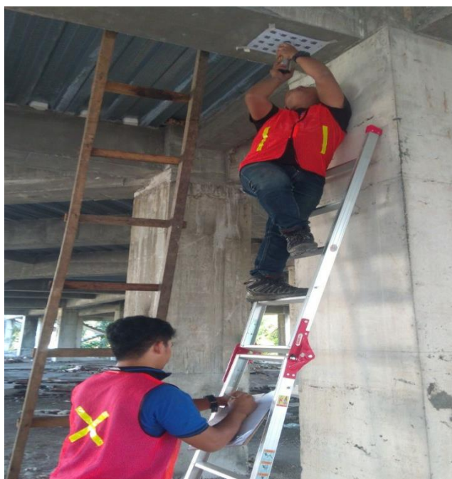
Pengujian Hammer Test pada gedung kuliah pendidikan terpadu politeknik negeri manado
