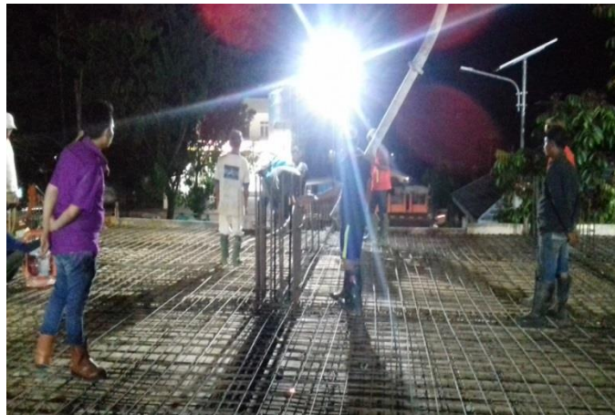
Gambar 4.27 Proses pengecoran balok pada bangunan Puskesmas Paniki Bawah
