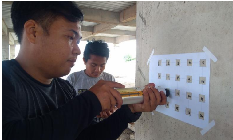
Gambar 3.4 Pengujian Hammer Test pada kolom bangunan kuliah pendidikan terpadu Politeknik Negeri Manado
