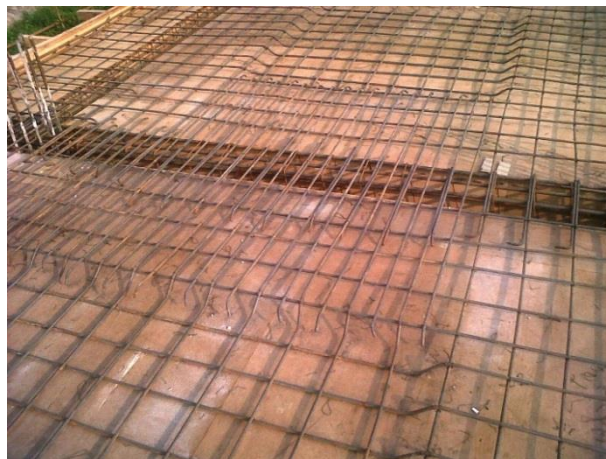
Gambar 4.28 Proses pengecoran Plat pada bangunan Puskesmas Paniki Bawah
