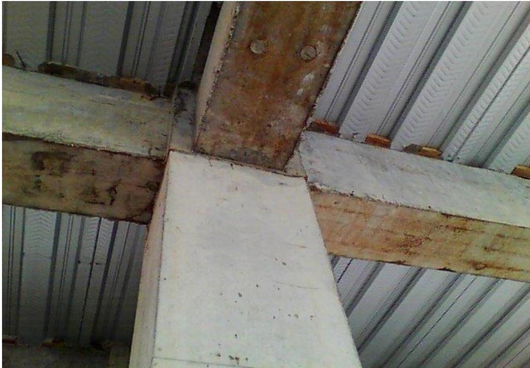
Gambar 4.11 Tampak pertemuan kolom dan balok bangunan Pendidikan Terpadu Politeknik Negeri Manado
