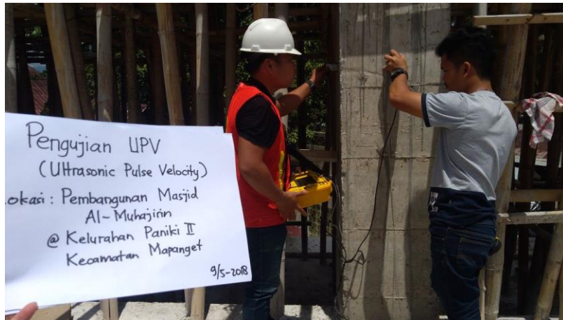
Pengujian UPV pada kolom bangunan Masjid Al-Muhajirin
