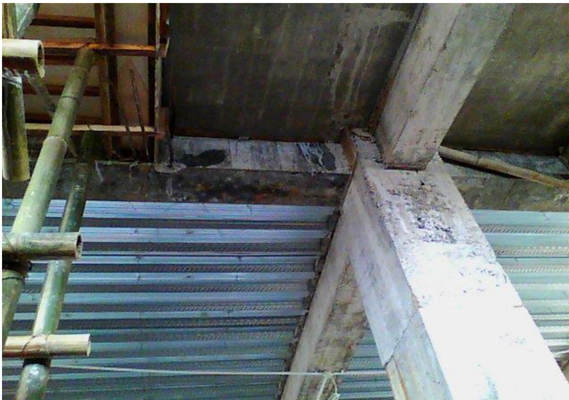
Gambar 4.3 Tampak pertemuan kolom & balok bangunan Masjid Al-Muhajirin
