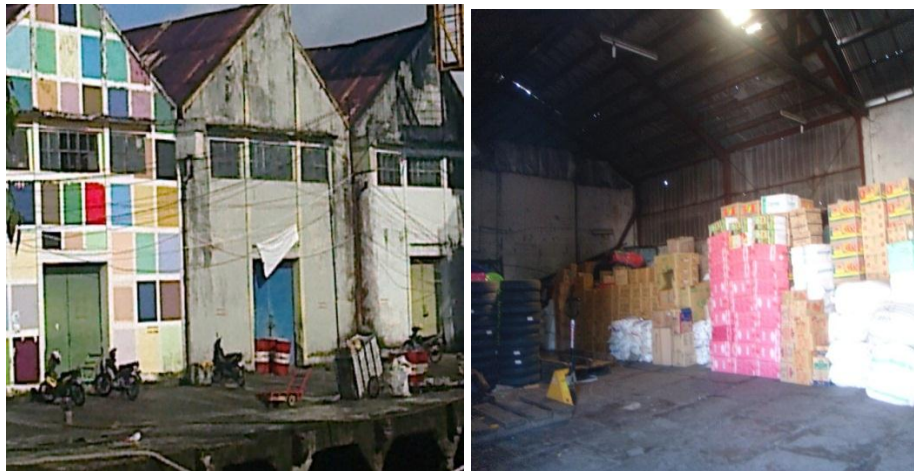
Gambar 3: Gudang Transito Penyimpanan
