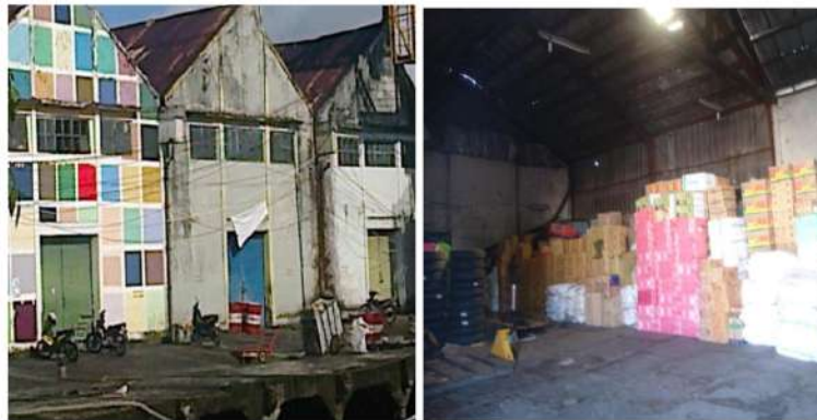
Gambar 3: Gudang Transito Penyimpanan
