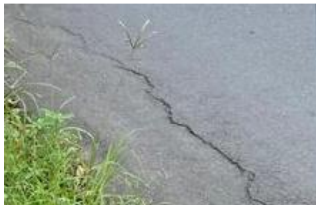
Gambar J-8 Retak Memanjang
