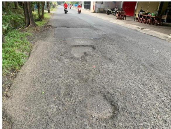
Gambar J-2 Kerusakan Retak Pinggiran
