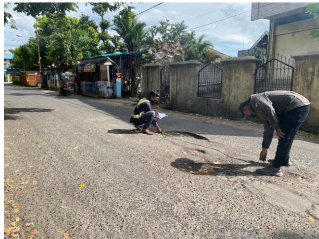
Gambar K-8. Pengukuran Kerusakan Pelepasan Butir
