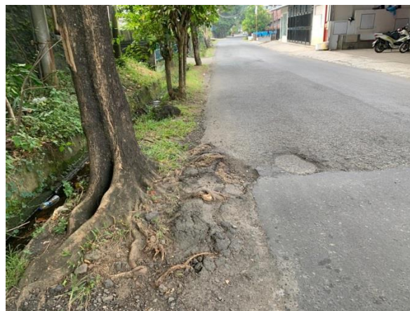
Gambar J-2 Kerusakan Retak Pinggiran
