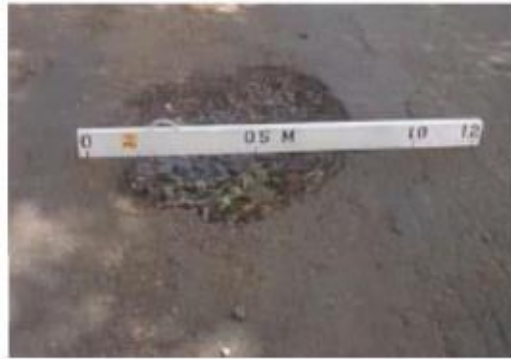
Gambar 2.28 Contoh Lubang
