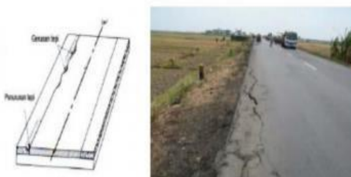
Gambar 2.16 Contoh Retak Samping
