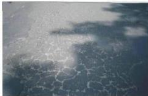
Gambar 2.40 Contoh Pelepasan Butir
