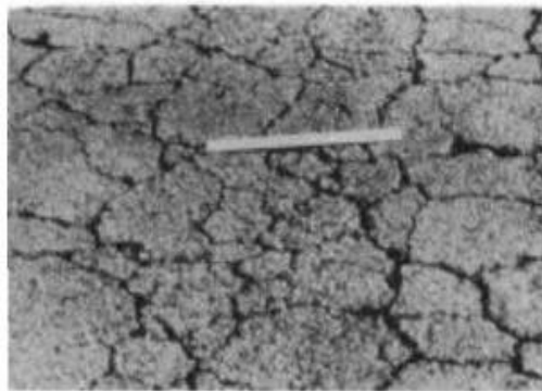
Gambar 2.4 Contoh Retak kulit Buaya
