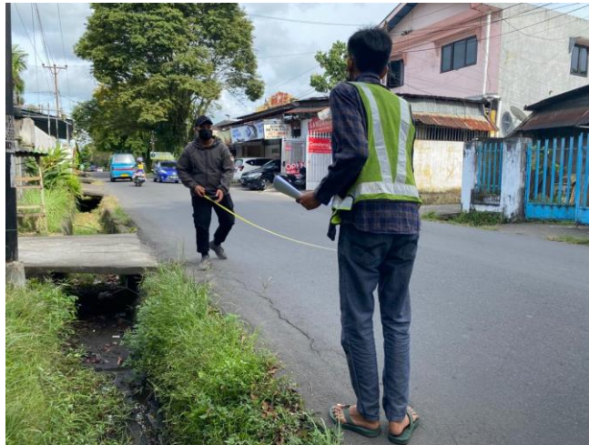
Gambar K-8. Pengukuran Kerusakan Pelepasan Butir
