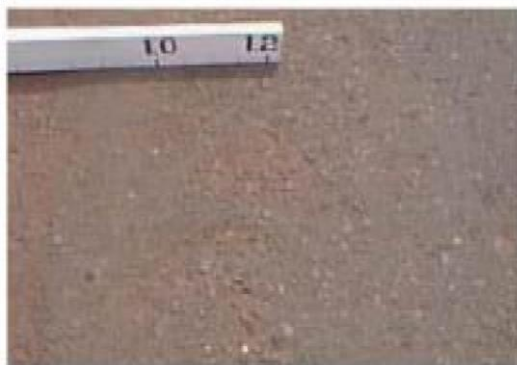
Gambar 2.24 Contoh Pengausan Sumber: Bina Marga No. 03/MN/1983
