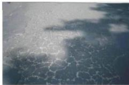
Gambar 2.38 Contoh Pelepasan Butir Sumber: Bina Marga No. 03/MN/1983
