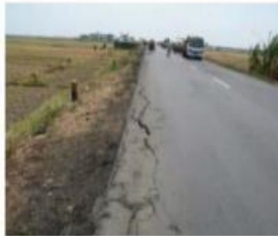
Gambar 2.14 Contoh Retak Samping Sumber: Bina Marga No. 03/MN/1983
