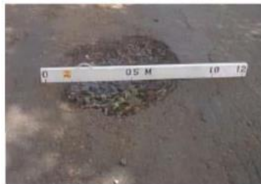
Gambar 2.26 Contoh Lubang Sumber: Bina Marga No. 03/MN/1983
