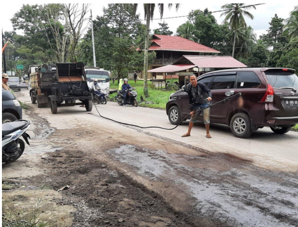
Gambar 3.3.1 Penyemprotan Tack Coat
