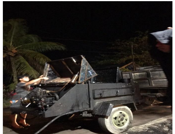
Gambar 3.3.1 Penyemprotan Tack Coat
