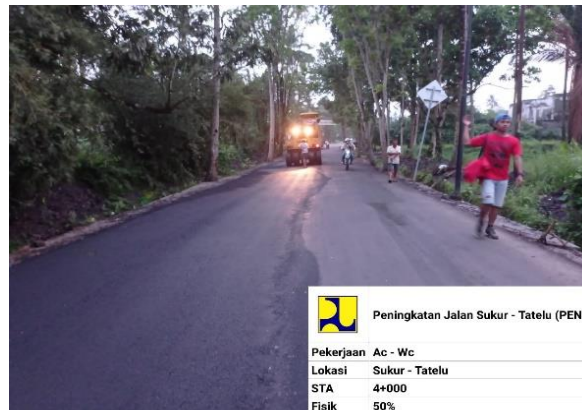
Gambar 3.3.4 Proses Pematatan Kedua Menggunakan Pneumatic Tire Roller
