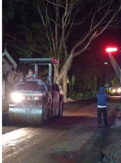
Gambar 3.3.3 Proses Pemadatan Pertama Menggunakan Thundem Roller
