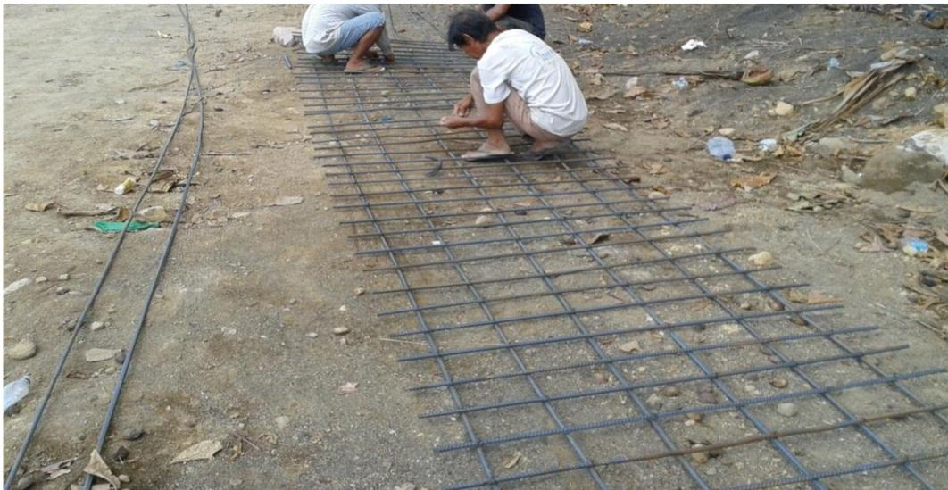
Gambar Pekerjaan Pembesian Cross Drain
