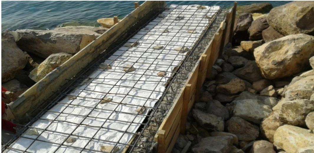
Gambar Pembesian Plat Atas Cross Drain
