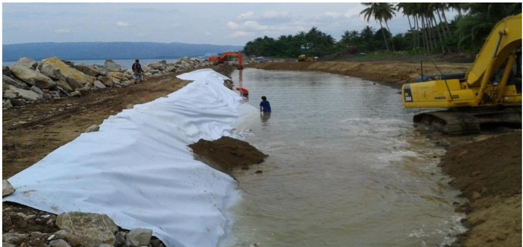
Gambar Pekerjaan Geotextile di Sisi Batu Kosong
