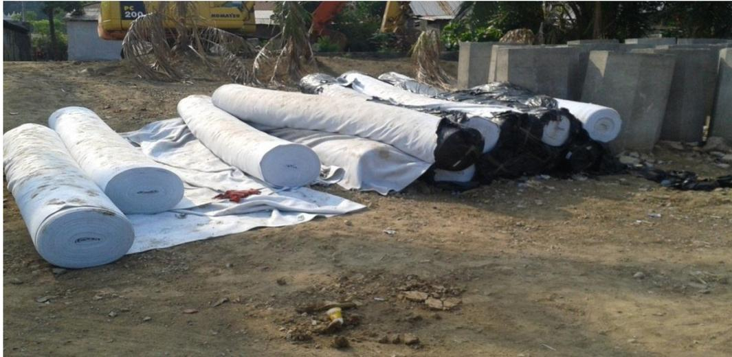
Gambar Tumpukan Geotextile
