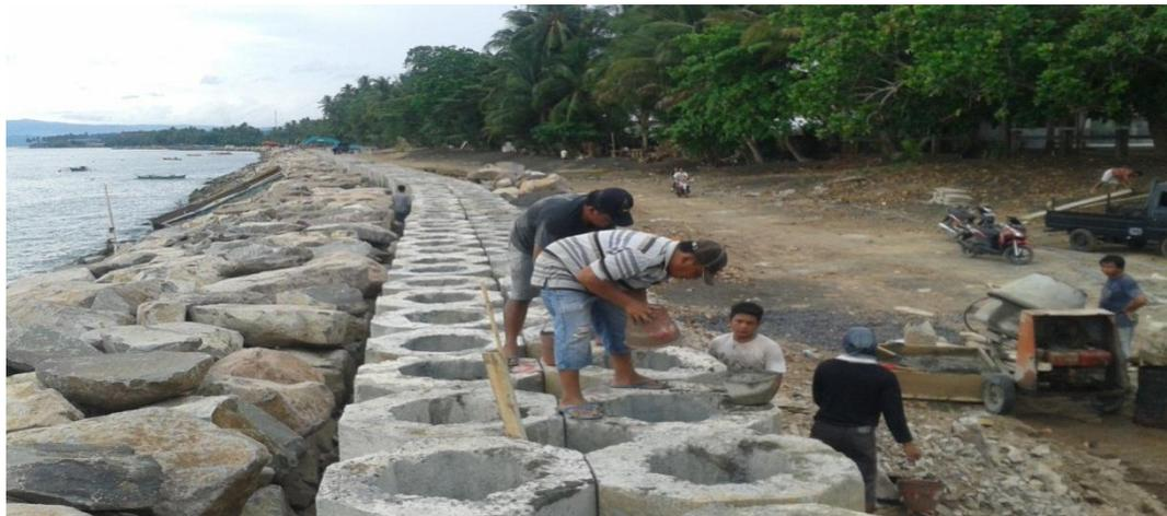
Pengecoran Beton Cyclop (Bawah)
