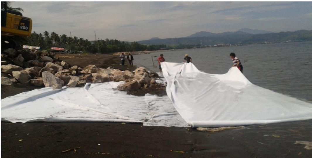
Gambar Pekerjaan Pemasangan Geotextile
