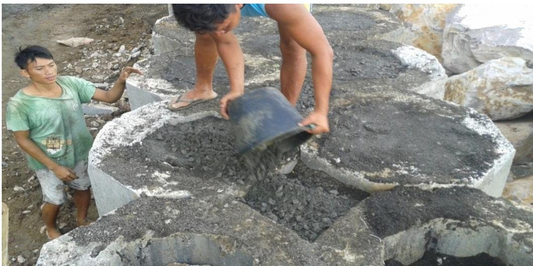
Pengecoran Beton Cyclop (Atas)
