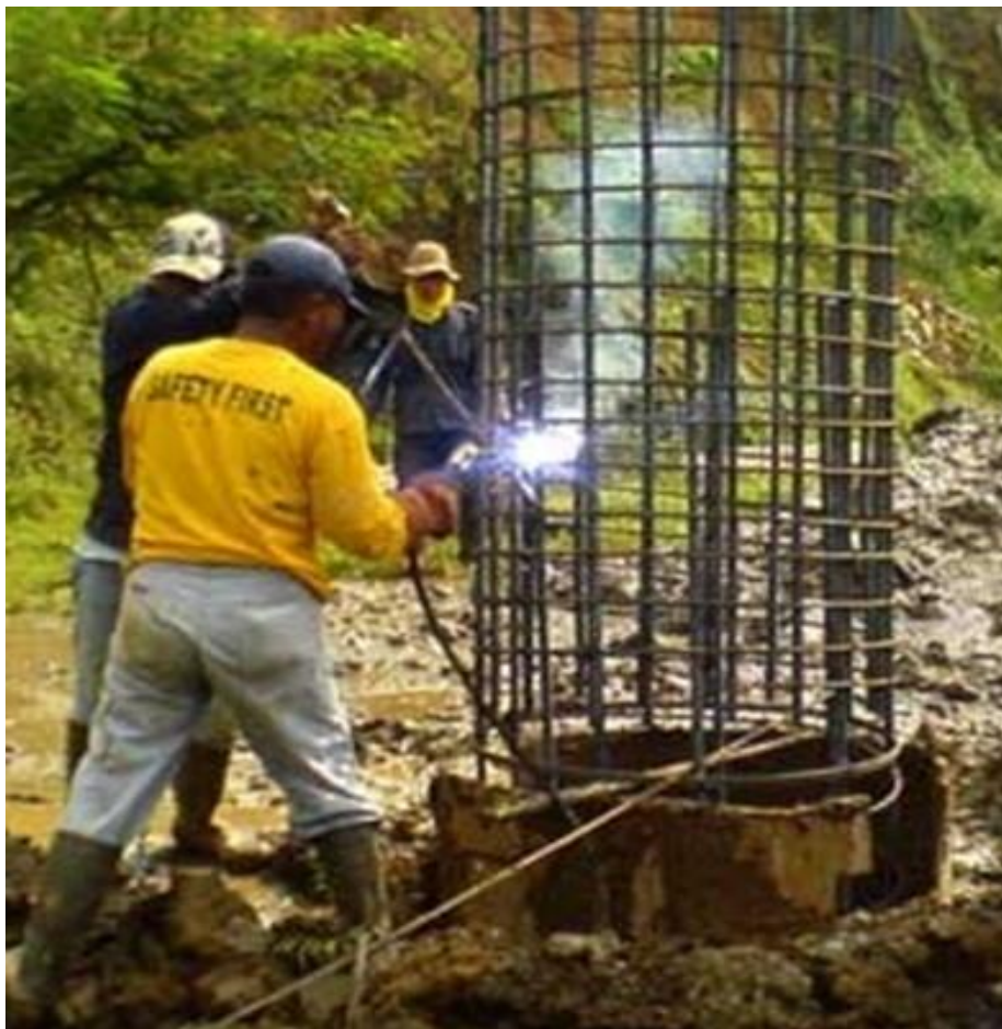
Gambar 3.18 Penyambungan tulangan pondasi
