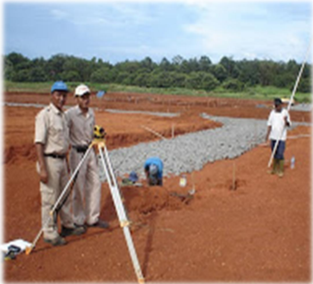
Gambar 3.14 Mengukur dan menentukan posisi titik koordinat bored pile dengan Bantuan alat Theodolite
