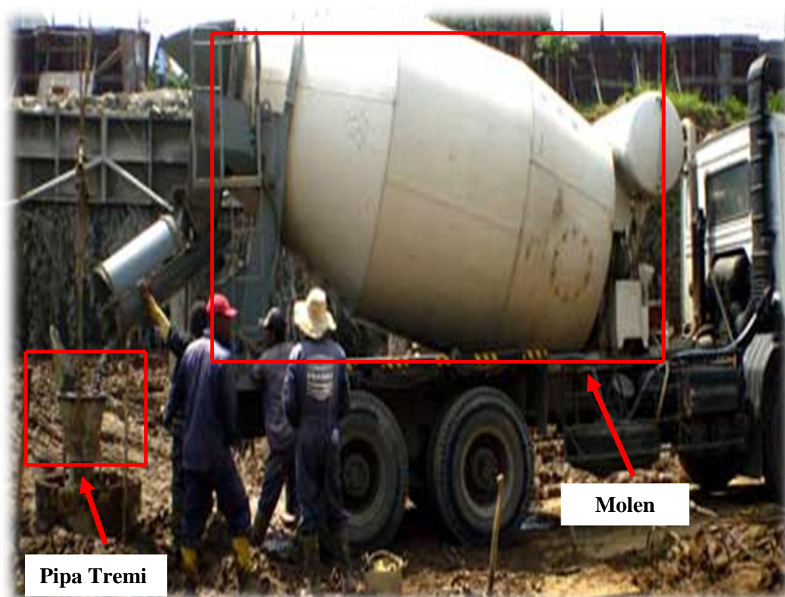
Gambar 3.20 Truk readymix saat melakukan pengecoran pondasi bore pile
