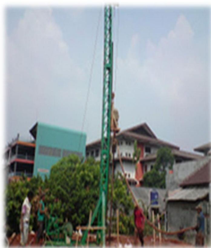
Gambar 2.8 Pembuatan bored pile mini crane
