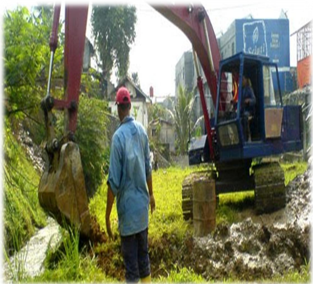
Gambar 3.13 Excavator mempersiapkan areal proyek agar alat berat bisa masuk.
