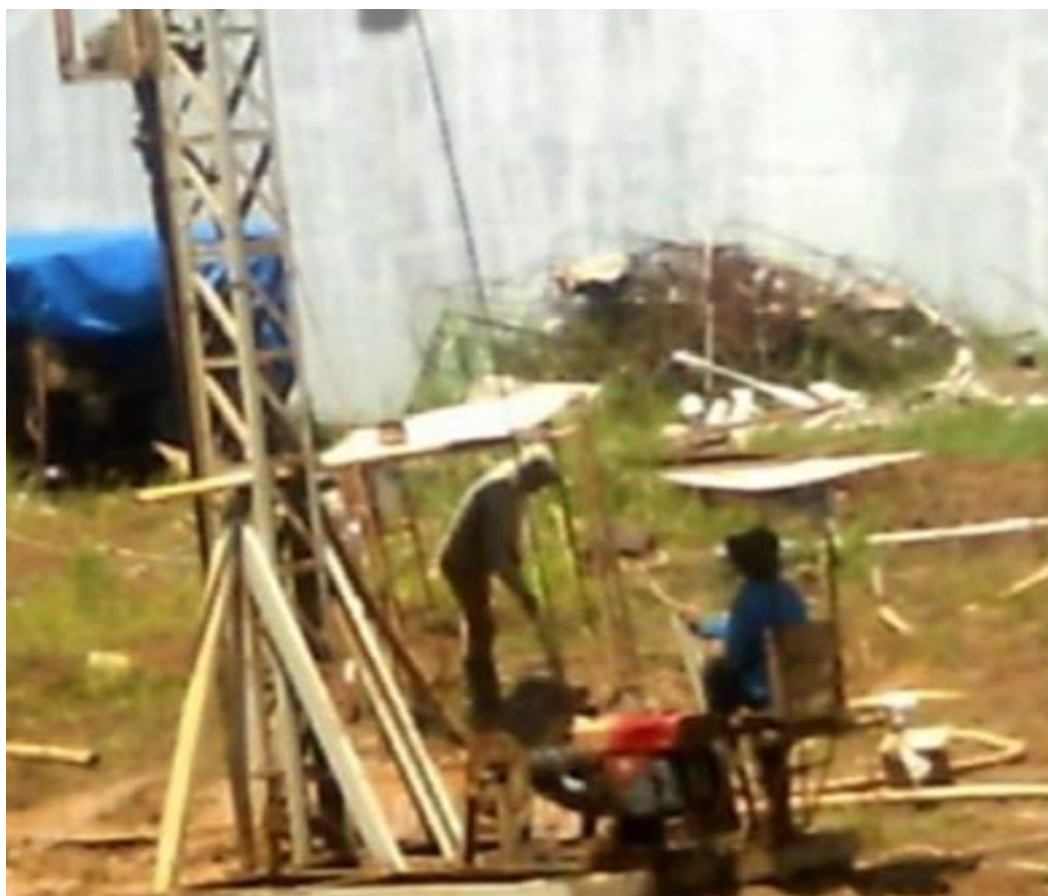
Gambar 3.16 Proses Pengeboran Menggunakan Mesin Bor
