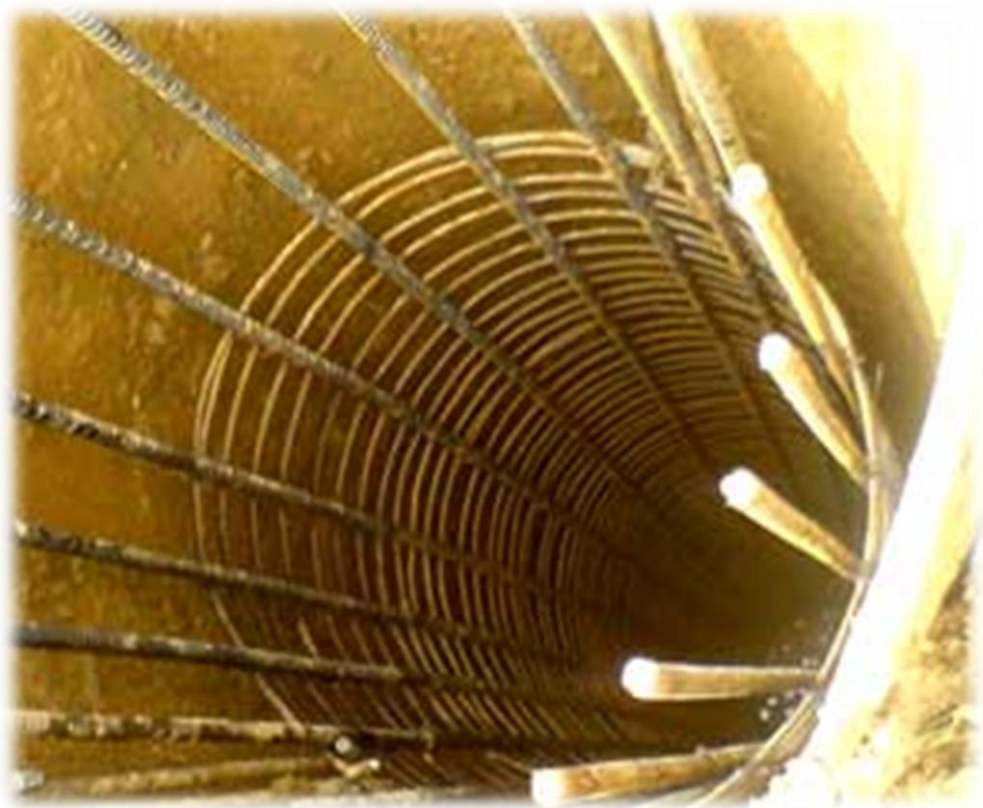
Gambar 3.19 Kondisi lubang pondasi yang telah siap di cor
