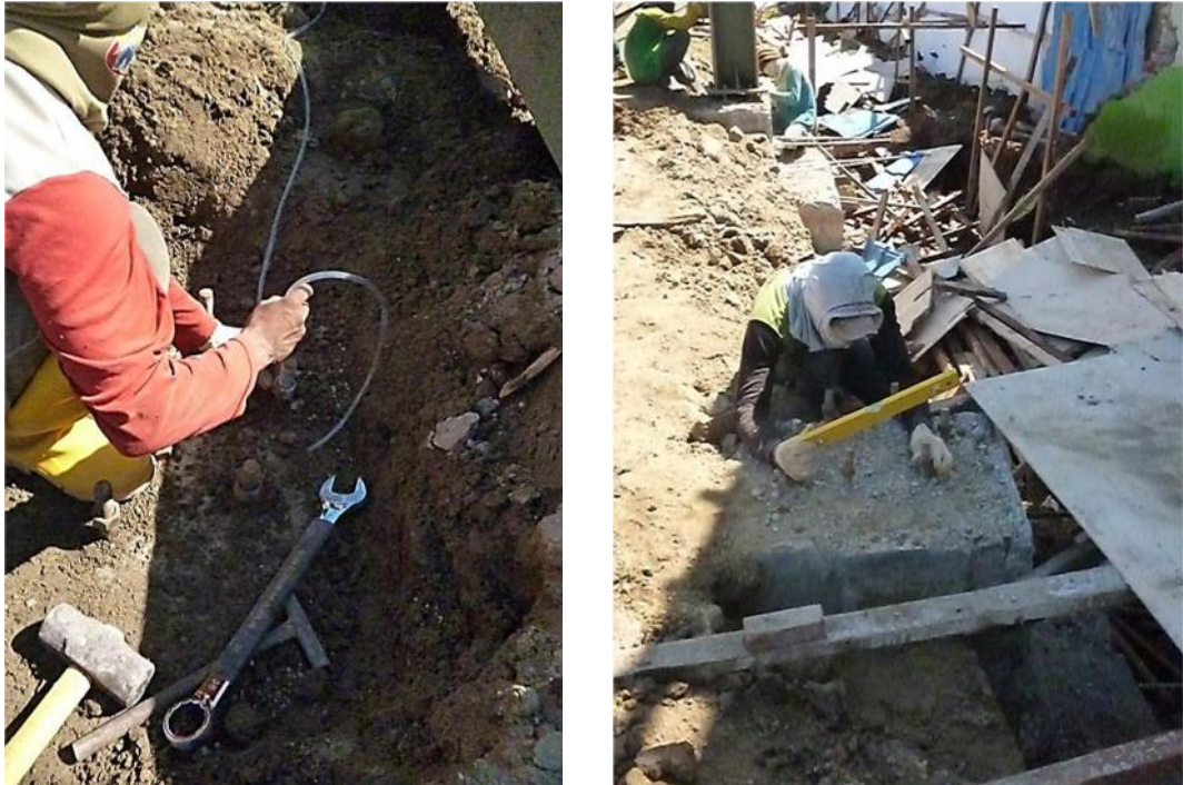
Gambar 3.10 Dudukan baut kolom yang diwaterpas
