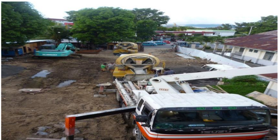
Gambar 3.26 Kolaborasi kendaraan Mix dan kendaraan pemompa campuran
