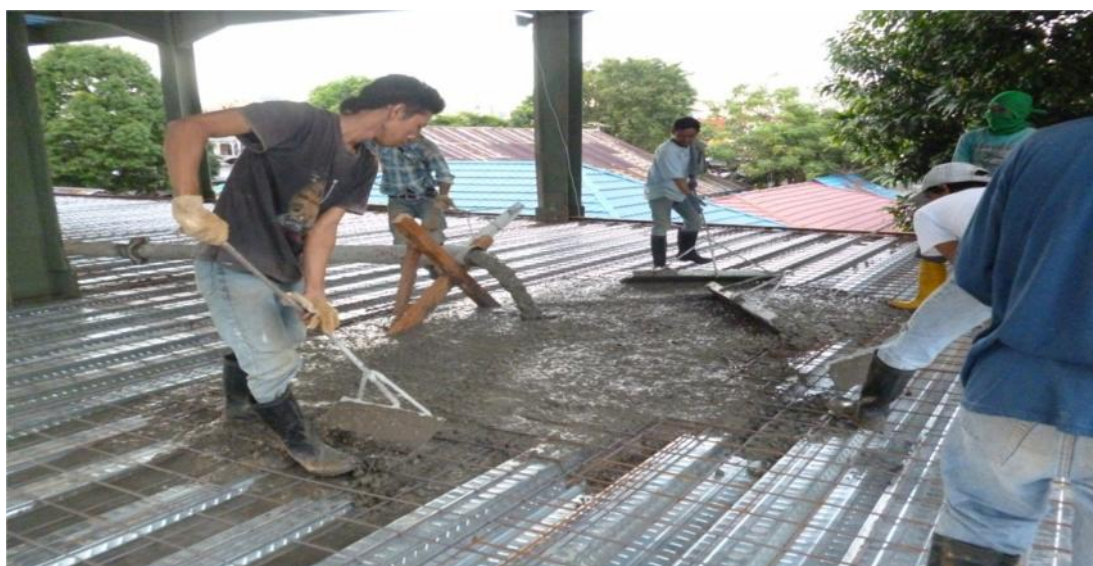
Gambar 3.28 Proses Pengecoran
