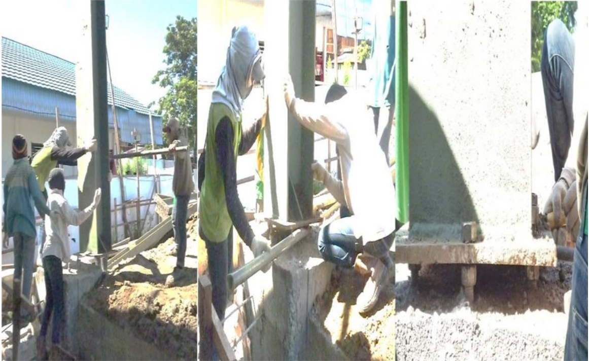
Gambar 3.14 Penyetelan ketegakan tiang kolom
