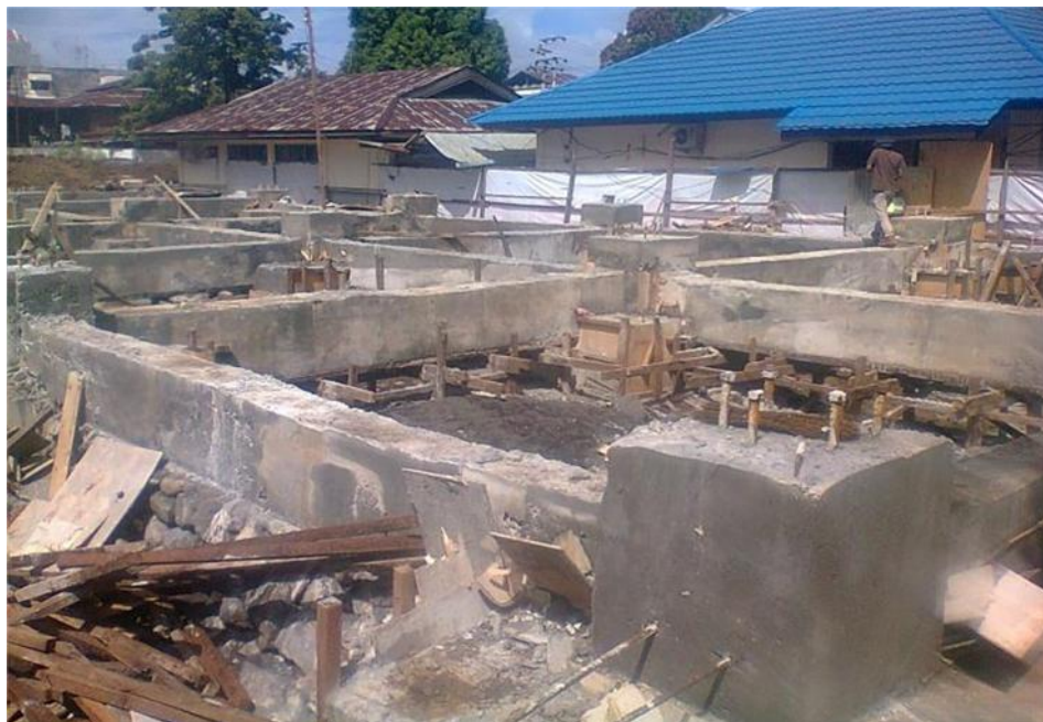
Gambar 3.8 Struktur bawah yang telah selesai dilaksanakan
