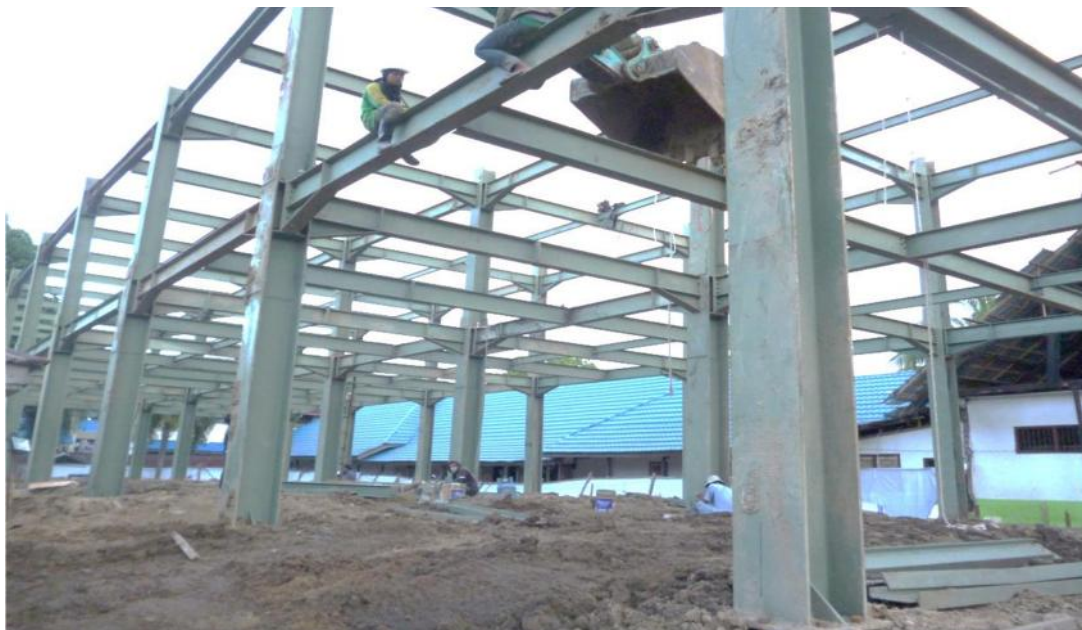
Gambar 3.21 Struktur kolom dan balok yang telah selesai dipasang
