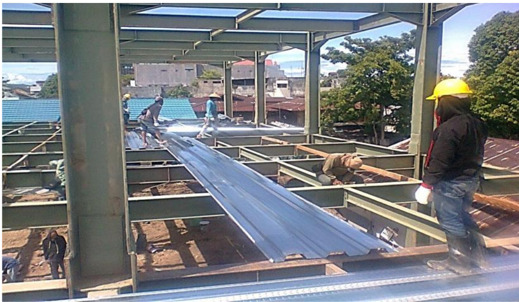
Gambar 3.22 Pemasangan plat Bondeks
