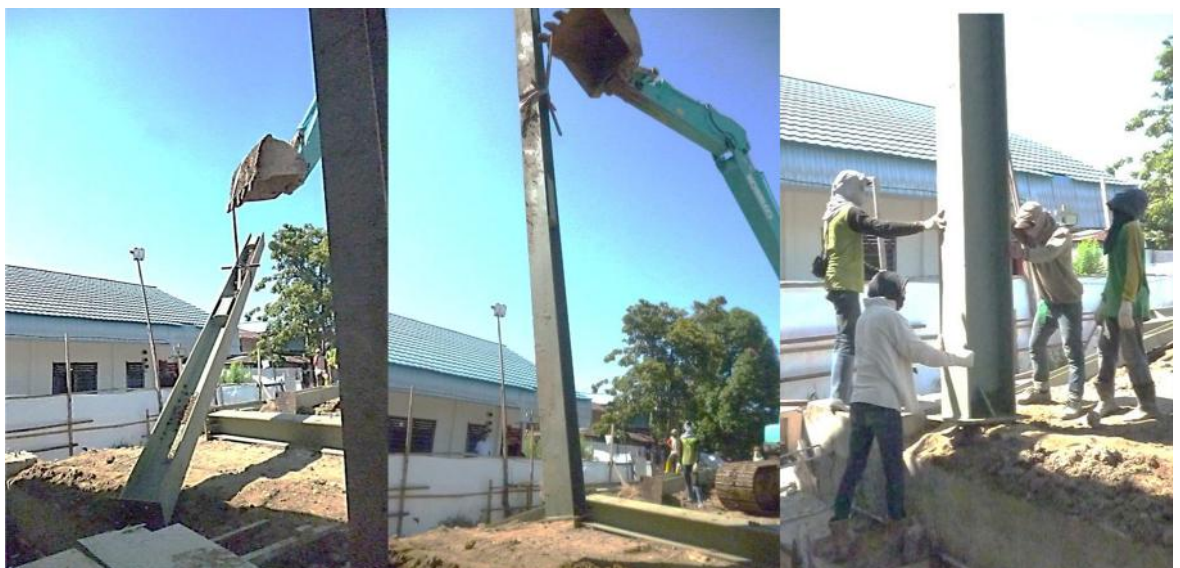
Gambar 3.13 Proses mendirikan tiang kolom
