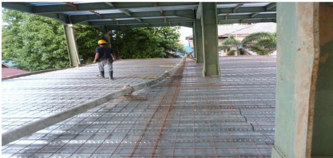
Gambar 3.27 Selang pemompa campuran beton
