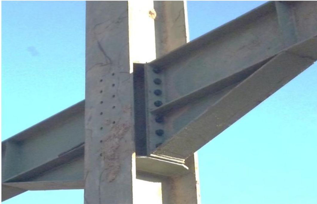
Gambar 3.19 Penampakan sambungan antara kolom dan balok
