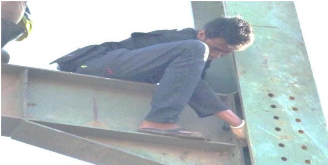
Gambar 3.18 Proses penyambungan balok dan kolom
