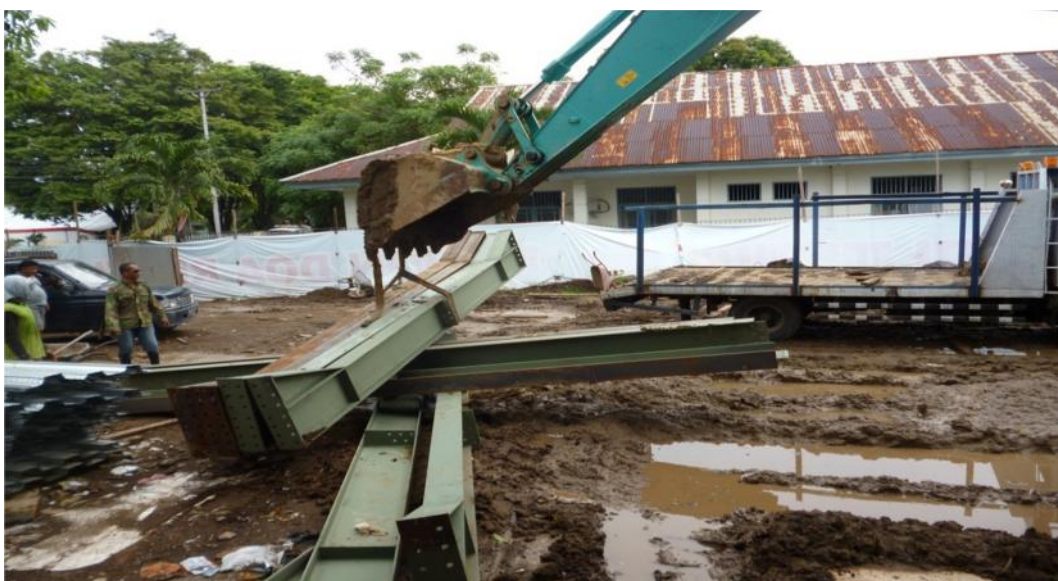
Gambar 3.11 : Tiang kolom dan balok baja yang diangkut ke lokasi kerja
