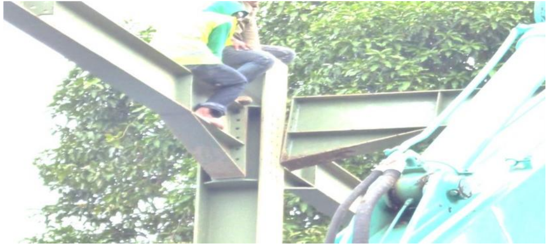
Gambar 3.17 Penyambungan antara balok induk dan kolom
