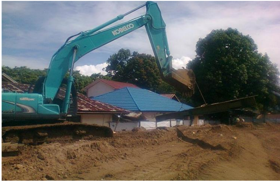
Gambar 3.9. : Pekerjaan urugan tanah kembali
