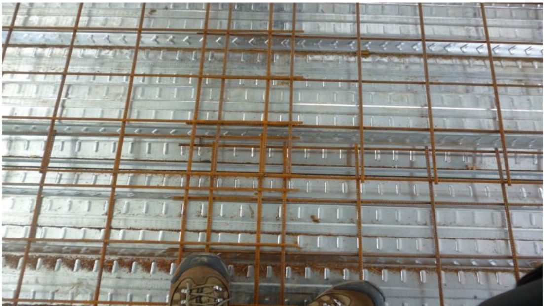
Gambar 3.25 panjang lewatan Wiremesh yang sudah terpasang
