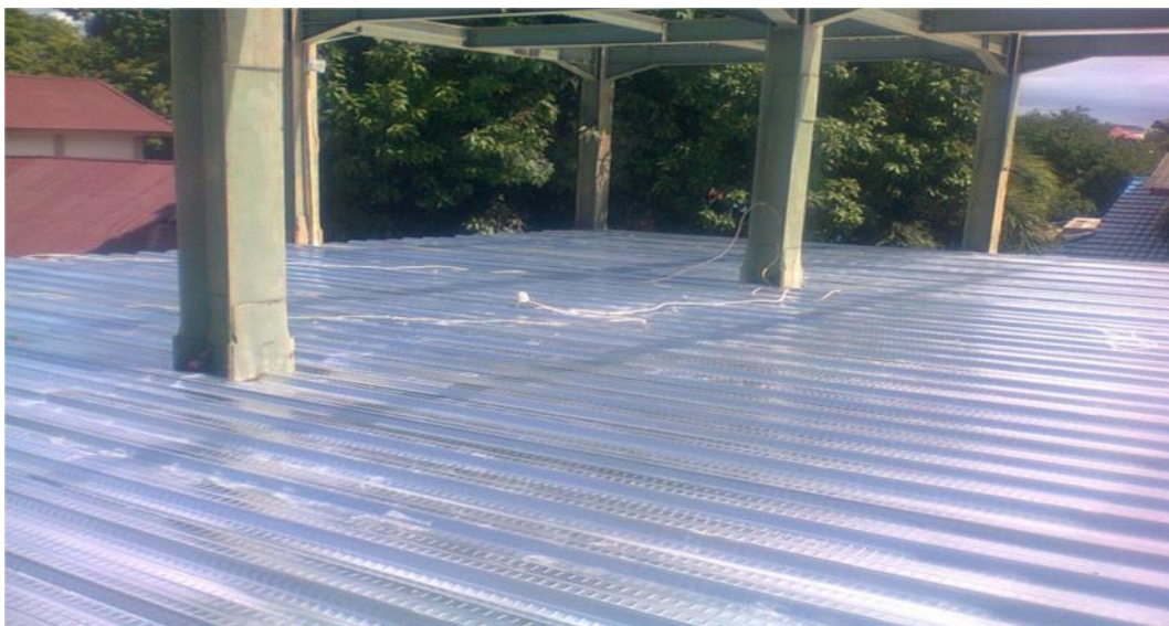
Gambar 3.23 Plat Bondeks yang telah terpasang
