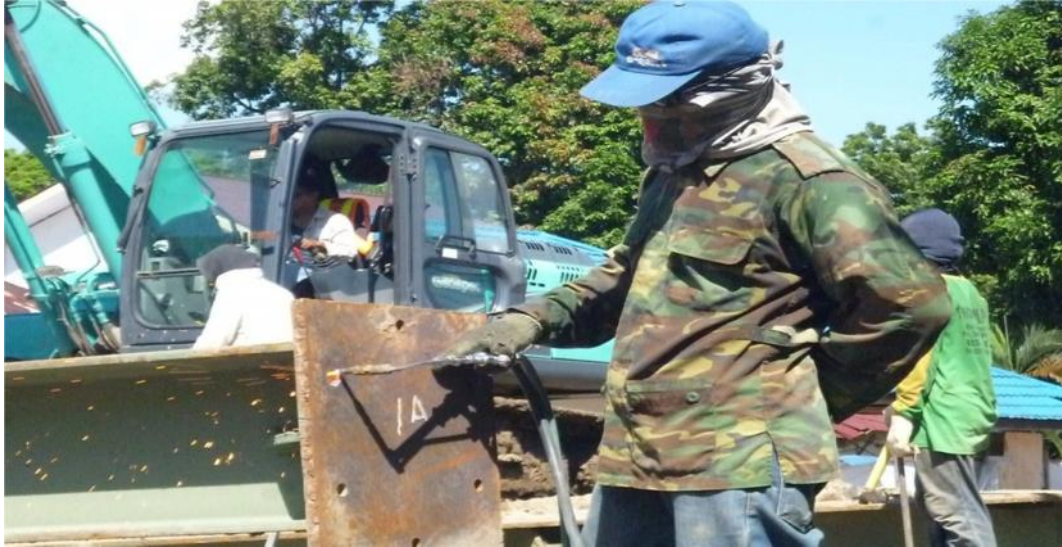
Gambar 3.12 Proses pembesaran lubang baut
