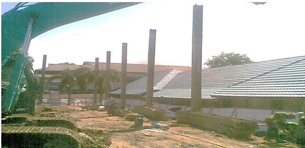
Gambar 3.15 Tiang kolom yang sudah didirikan
