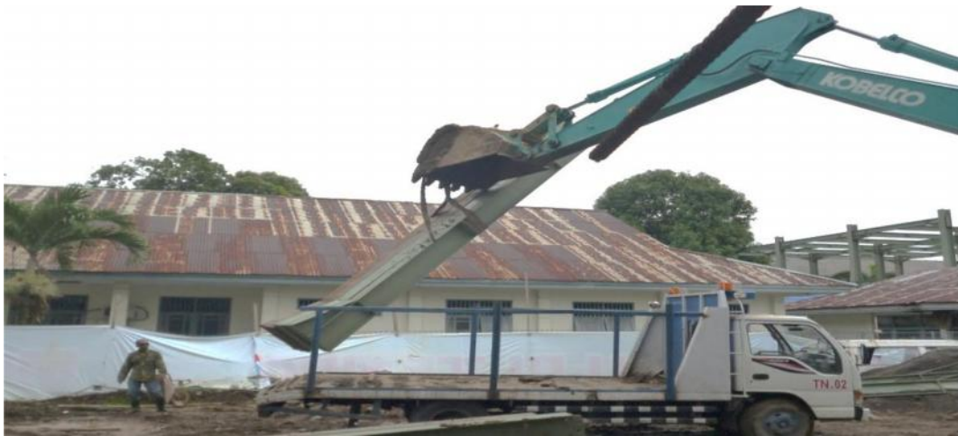
Gambar 3.16 Mobilisasi balok baja
