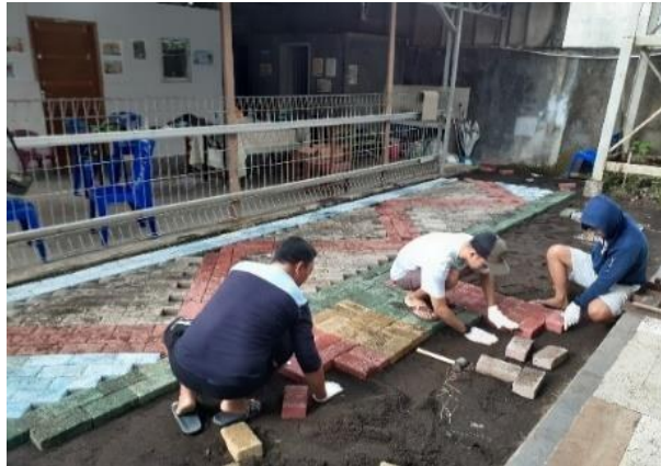
Gambar 4 Pemasangan Sumber: Penulis, 2024
