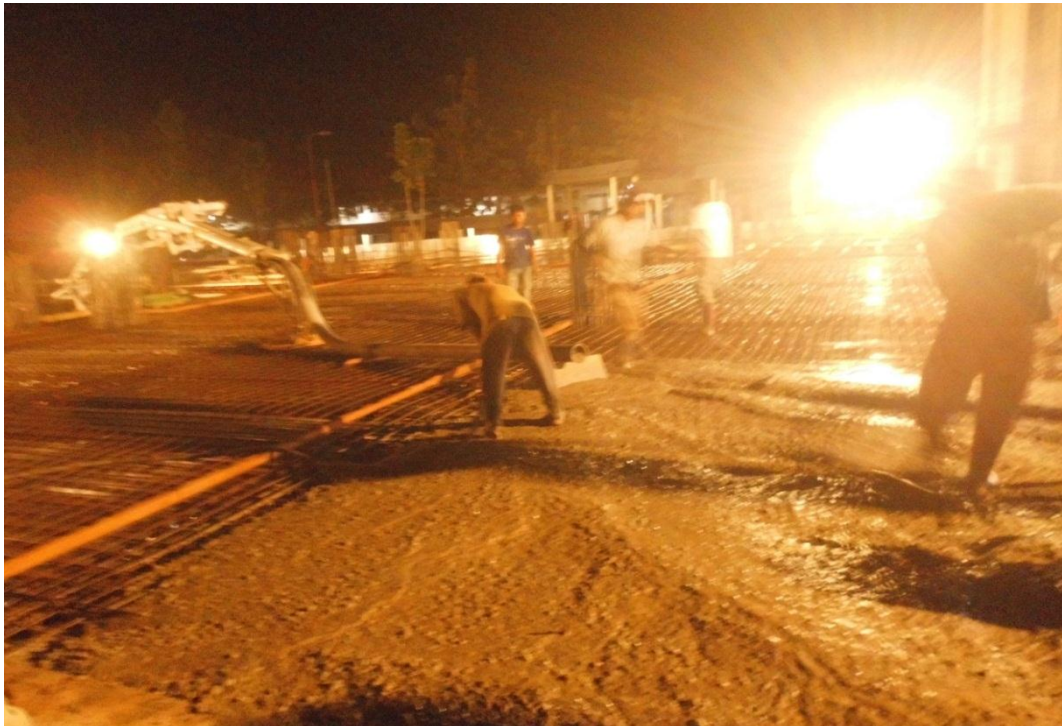
Gambar 3.6 Pengecoran pelat dan balok
