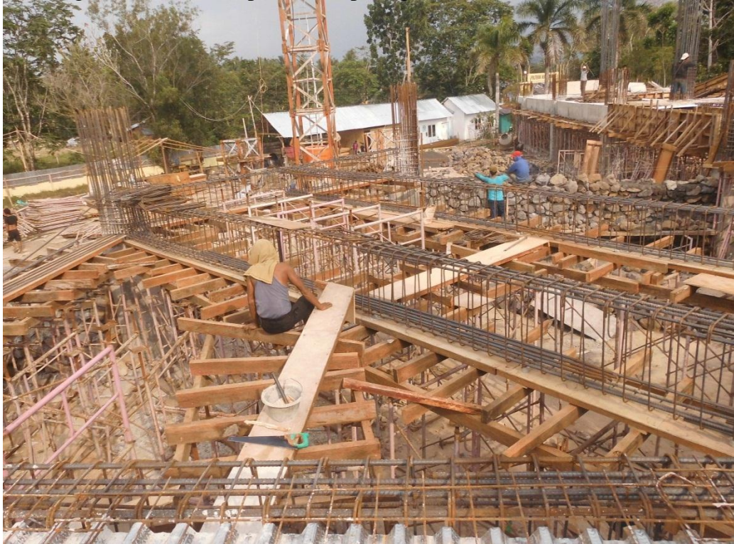
Gambar 3.4 Pembesian balok
