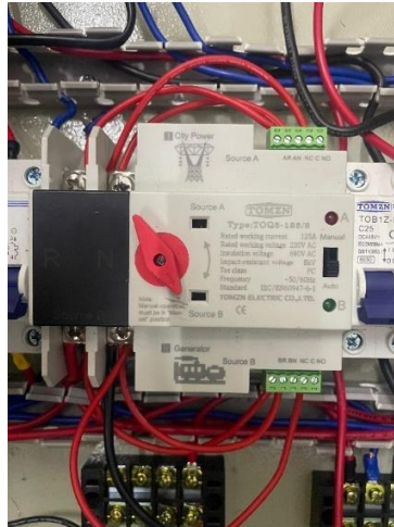
Gambar 3.10 Pemasangan ATS
