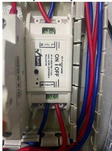
Gambar 3.11 Pemasangan Smart Switch
