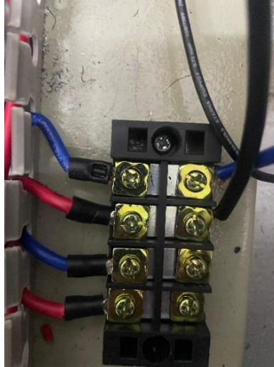
Gambar 3.14 Pemasangan Terminal Blok
