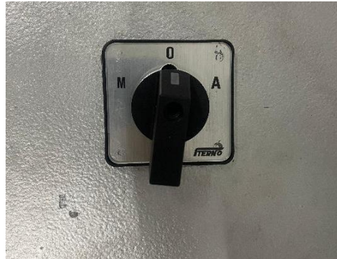
Gambar 3.16 Pemasangan Selector
