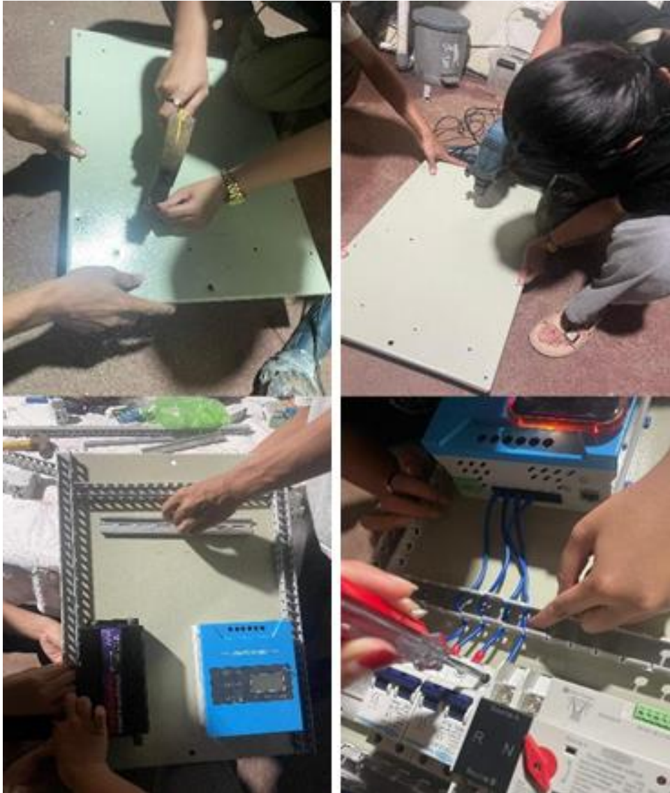
Gambar pembuatan kontrol box panel
