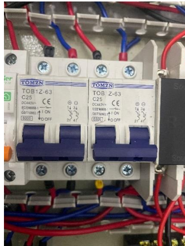
Gambar 3.13 Pemasangan MCB
