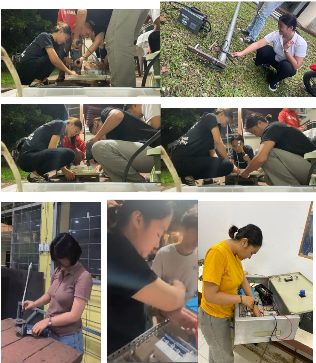
Gambar pemasangan smart surveillance
