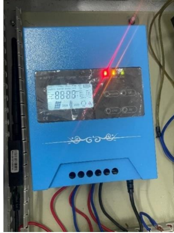
Gambar 3.8 Pemasangan MPPT
