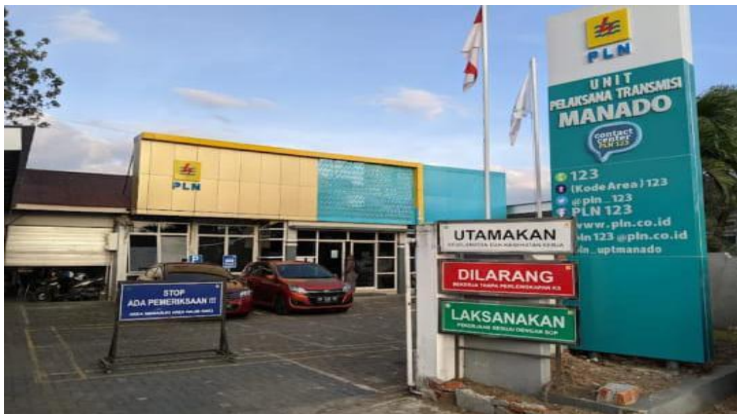
Gambar 3.4 Kantor PT. PLN (Persero) UPT Manado Sumber : PT. PLN (Persero) UPT Manado (2025)
