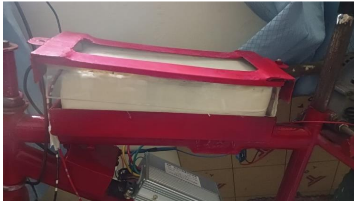
Gambar 3.12 Pembuatan penutup baterai
