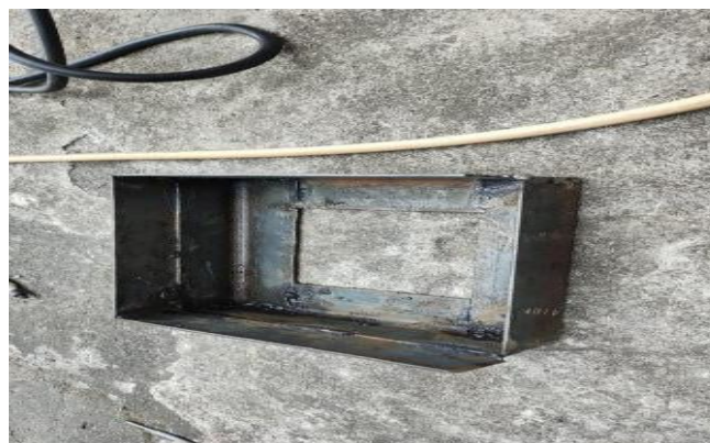
Gambar 3.8 Pembuatan dudukan baterai
