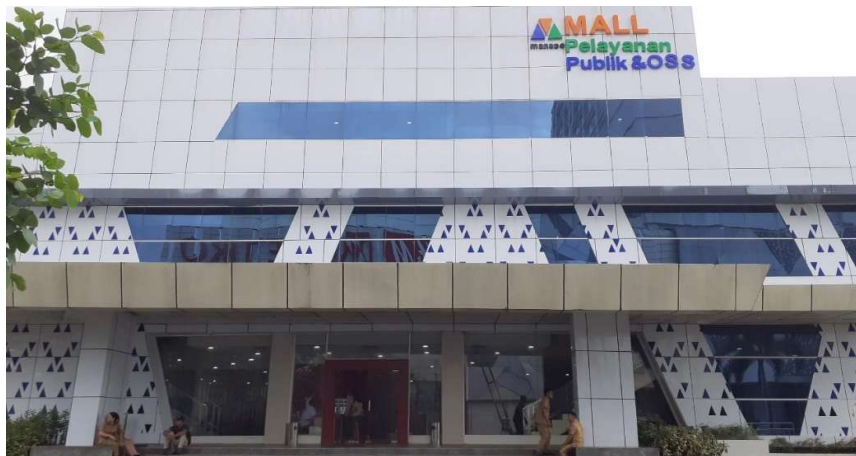
Gambar 5 Kantor Baru Badan Pendapatan Daerah (BAPENDA) Kota Manado Sumber : Kantor BAPENDA Kota Manado
