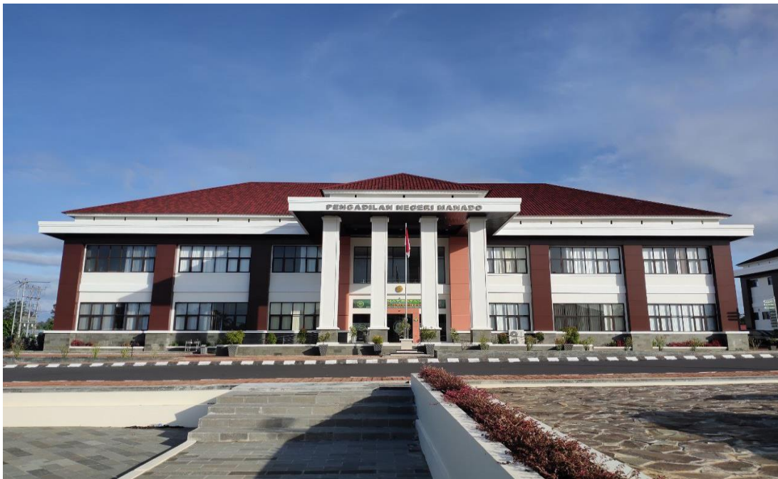
Gambar 1 Gedung Pengadilan Negeri Manado
