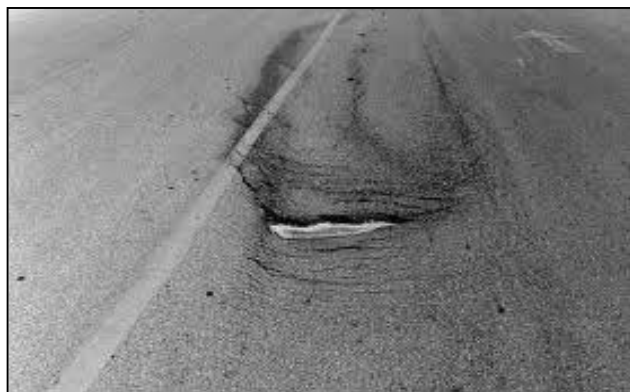
Gambar 2.12. Retak Slip
