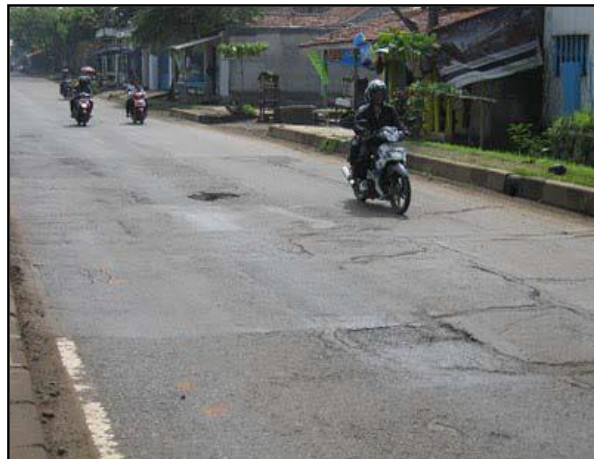
Gambar 2.11. Retak Susut
