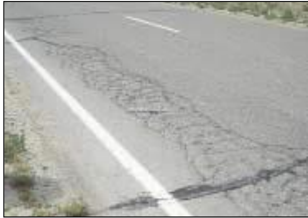
Gambar 2.6. Retak Kulit Buaya
