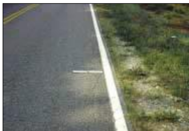
Gambar 2.7. Retak Pinggir
