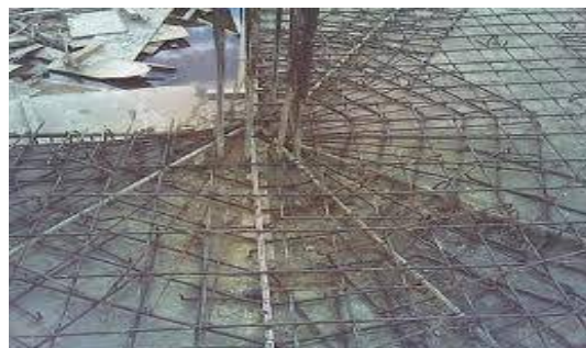
Gambar 2.4 Konstruksi Pondasi Sarang Laba-laba
