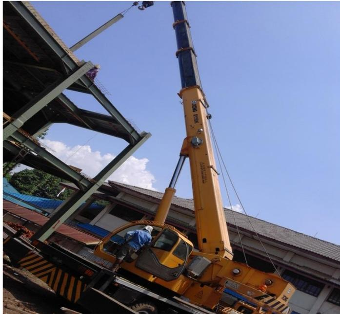
**Gambar 2.7** Alat Berat Mobile crane XCMG QY50K pada Proyek pembangunan RSJ Ratumbuysang
