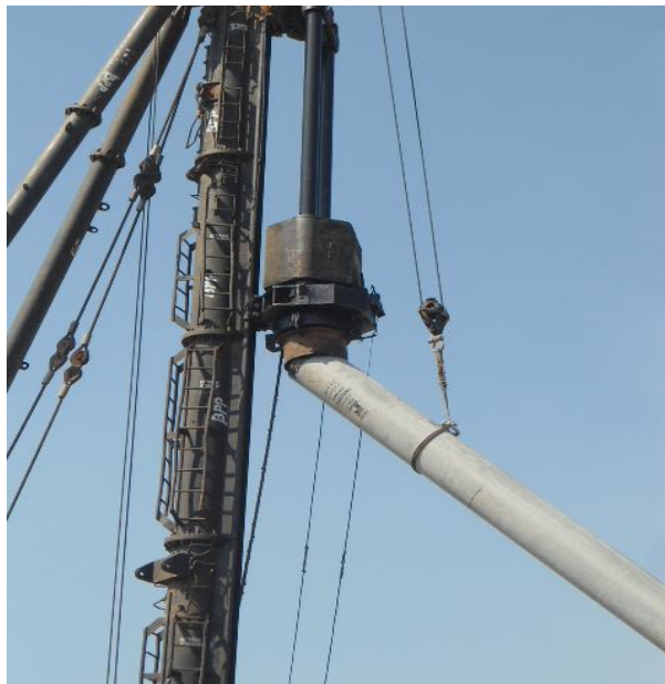
Gambar 2.22 Tiang Pancang Dimasukan pada Bagian Alat
