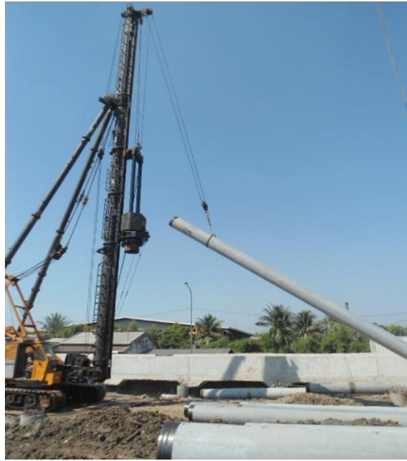
Gambar 2.21 Tiang Pancang Ditarik dengan Sling
