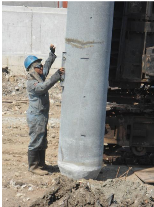
Gambar 2.24 Kemiringan Dicek Dengan Waterpass
