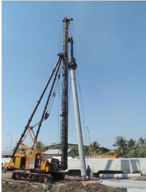
Gambar 2.23 Tiang Pancang Diluruskan
