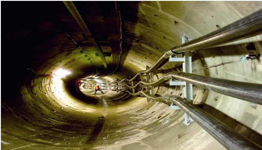
Gambar konstruksi kabel bawah tanah (NYFGbY)
