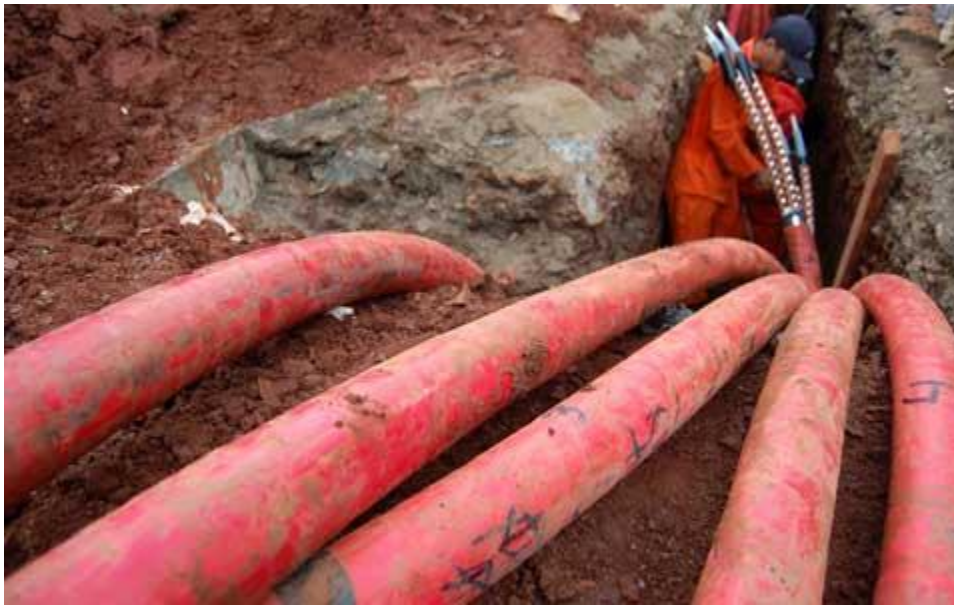
Gambar pemasangan kabel tanah (XLPE)
