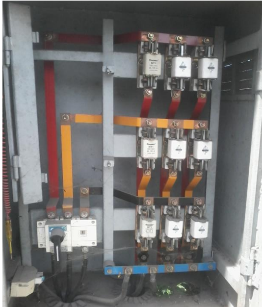
Gambar 2.5 Rangkaian dalam gardu
